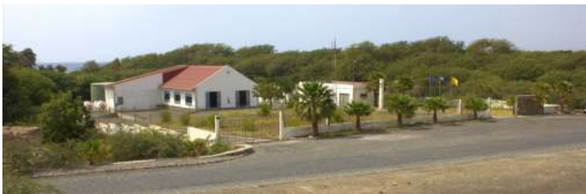
Figura 4.22 – Instalação de dessalinização da água do mar da APN. (Santo Antão). Fonte: Águas de Porto Novo SA.
