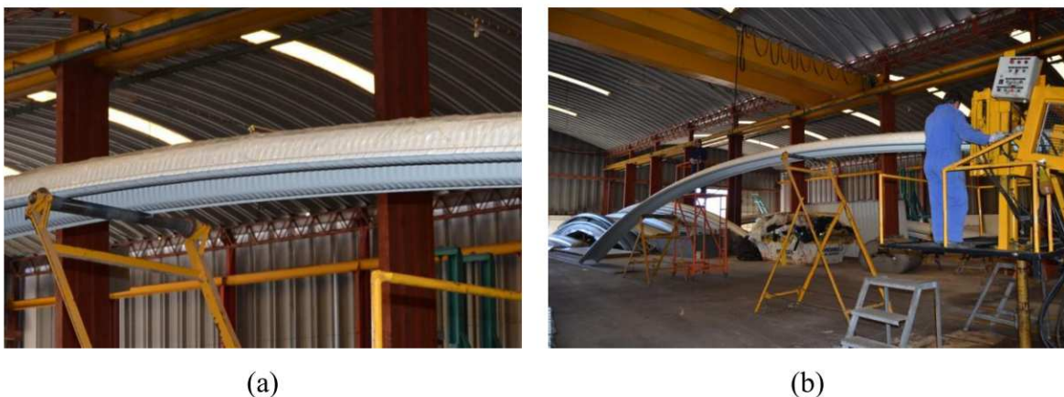
Figura 17 – (a) colocação de filme plástico de proteção e (b) cavaletes de apoio.
