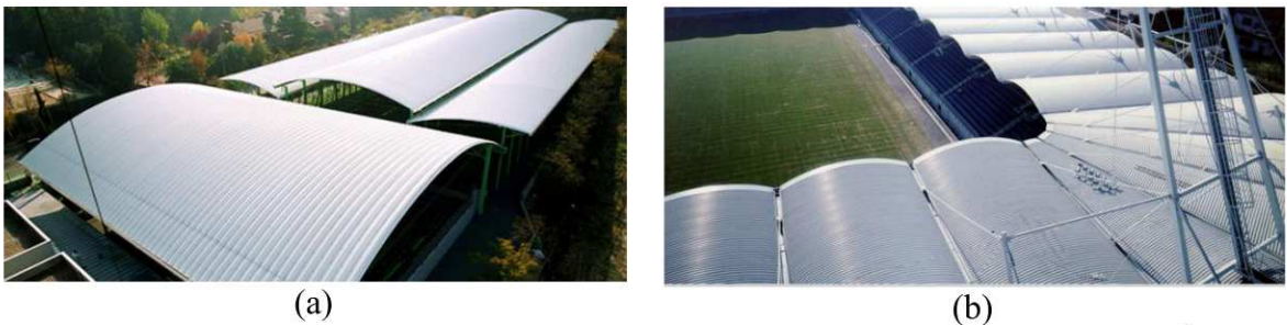
Figura 22 - Cobertura com telhas autoportante, (a) Pista de Padel Las Rosas e (b) estádio Áustria.
