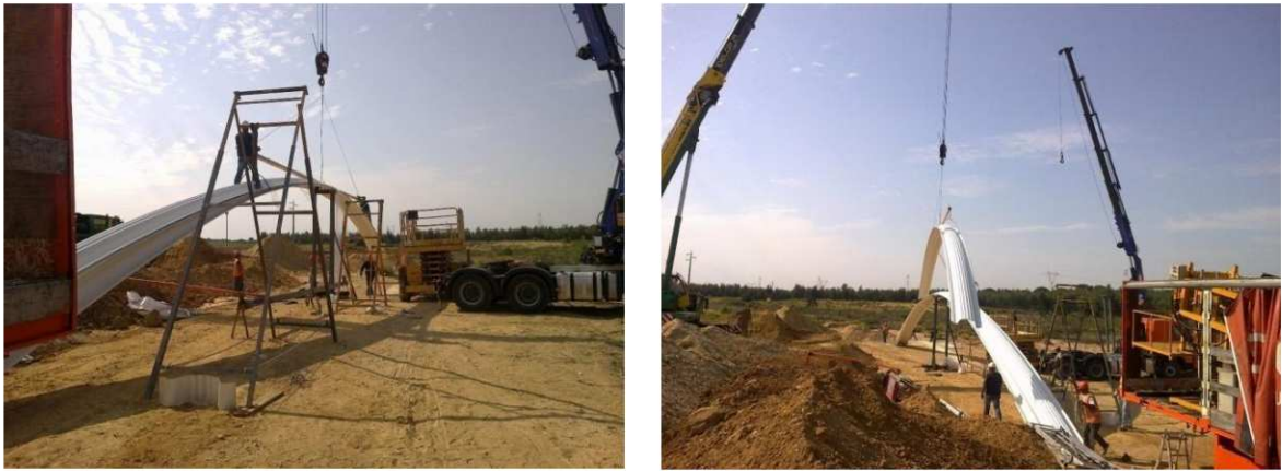
Figura 20 - Sistema de elevação das telhas de aço autoportantes.
