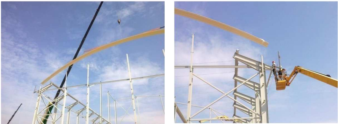
Figura 21 - Montagem das telhas de aço autoportantes.
