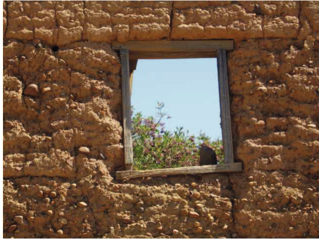
Figura 14 – Exemplo de tijolo em Adobe com adição de pedra miúda.
