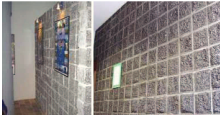
Figura 34 – Bloco de betão de argila expandida e sua aplicabilidade.
