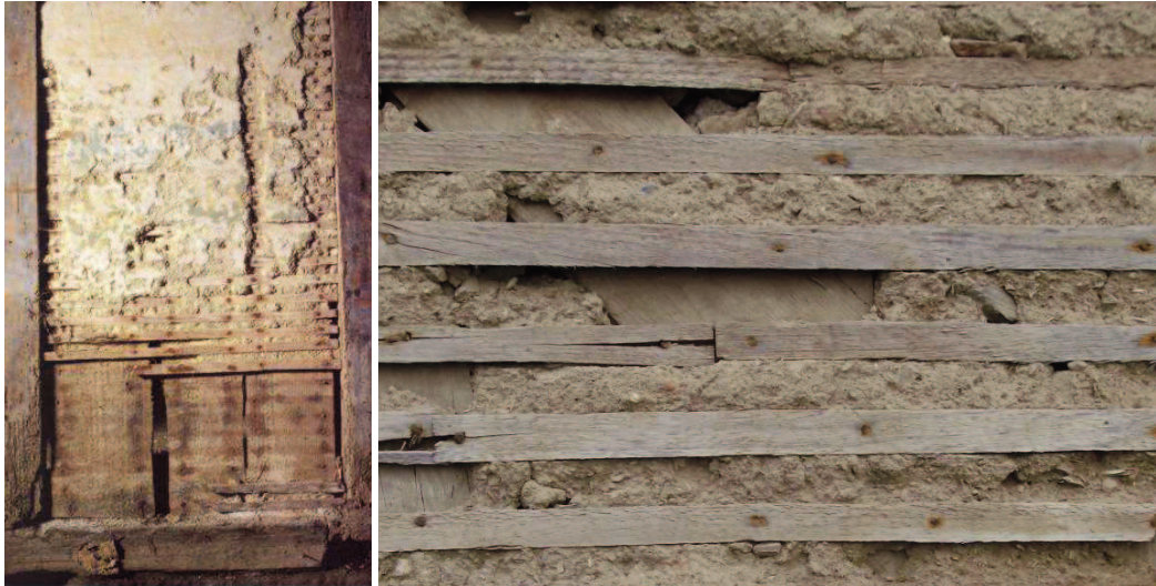
Figura 23 – Dois exemplos de paredes em taipa de fasquio.
