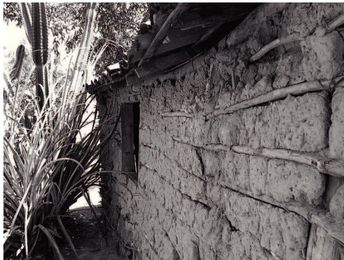
Figura 22 - Casa em Taipa de fasquio com reforço longitudinal em madeira
