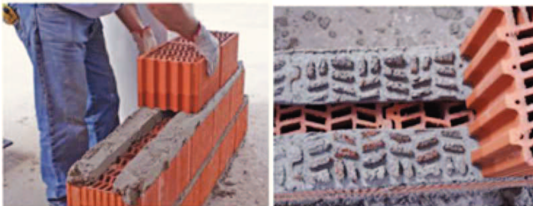
Figura 32 – Assentamento da camada superior de tijolo.
