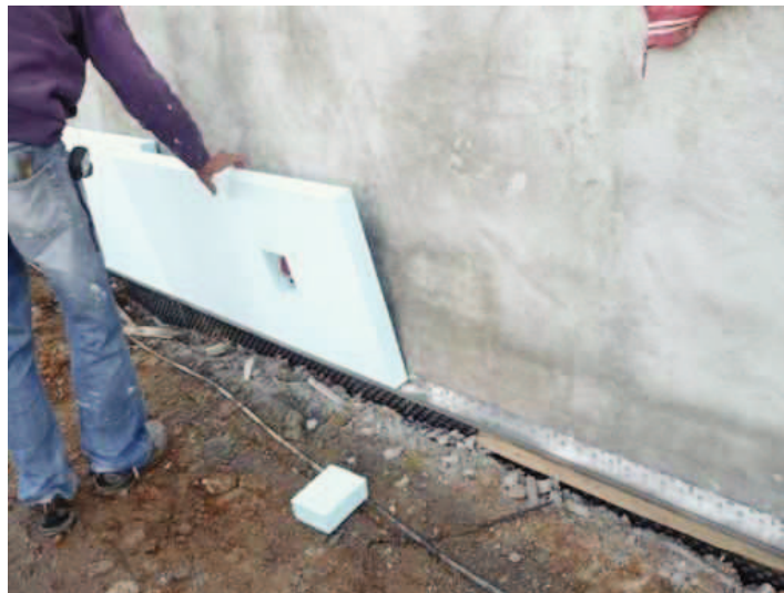
Figura 44 - Aplicação de placas EPS em parede
