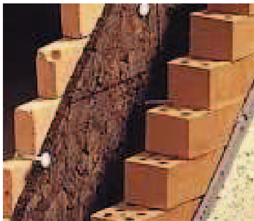
Figura 49 - Revestimento com aglomerado de cortiça
