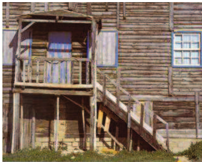
Figura 13 – Construção em madeira
