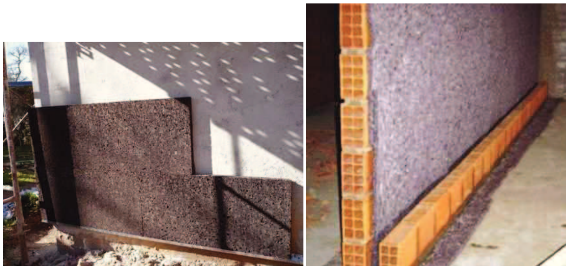
Figura 27 – Revestimento com aglomerado de cortiça e lã de rocha respectivamente.
