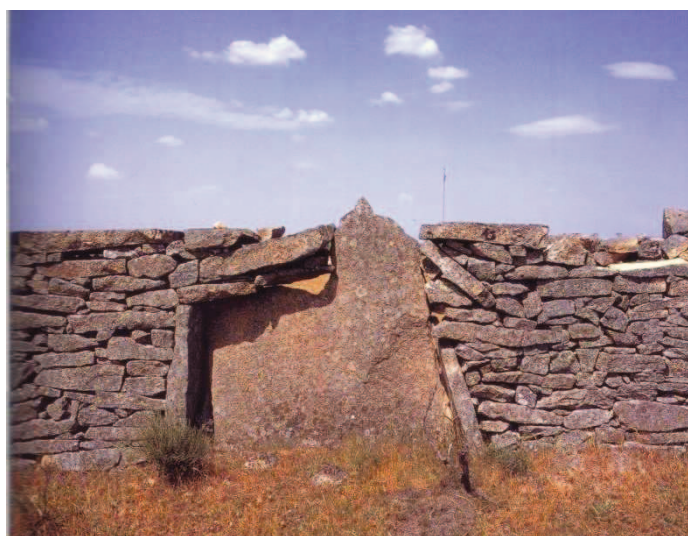
Figura 7 – Muro de protecção em pedra
