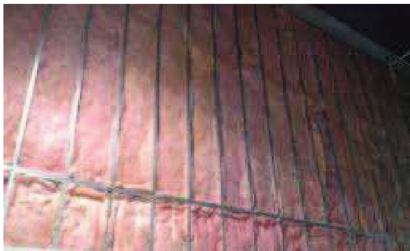
Figura 52 - Aplicação de lã de vidro
