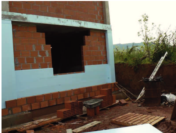
Figura 46 - Aplicação de placas de XPS em obra
