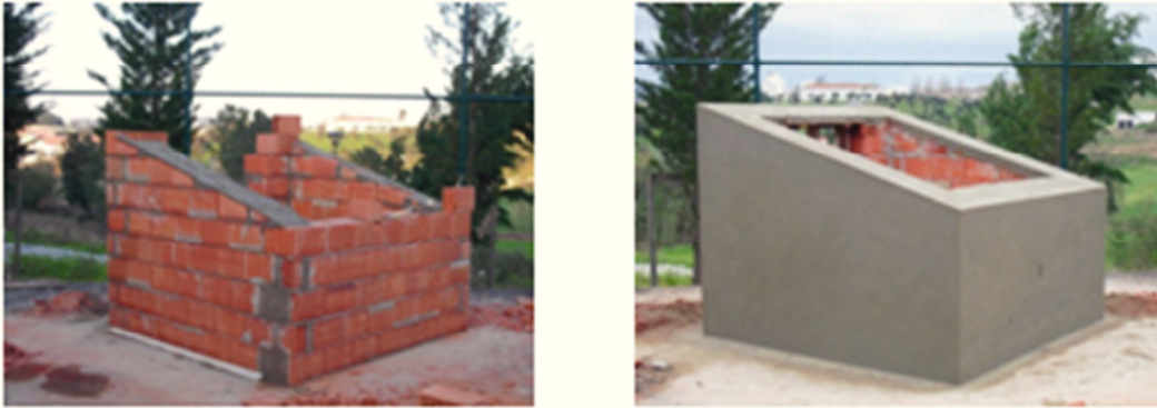
Figura 59 - Passos da construção da célula
