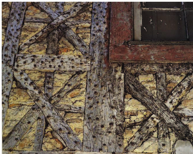
Figura 24 – Parede em taipa de rodízio.
