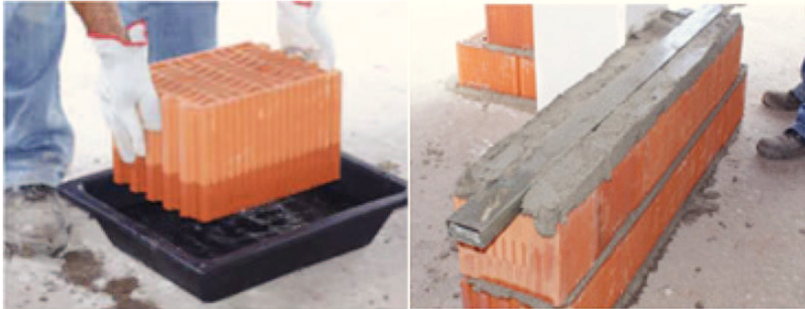
Figura 31 – Tijolo térmico humedecido e criação da junta de argamassa respectivamente
