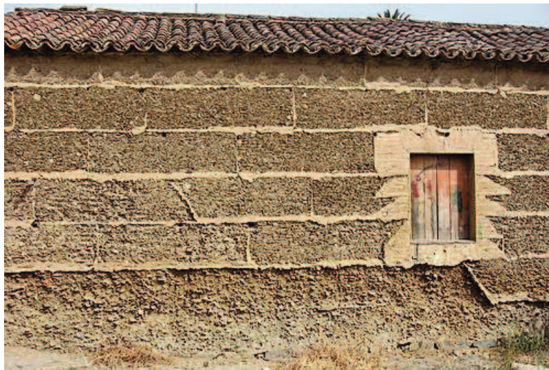
Figura 20 - Casa com parede em Taipa
