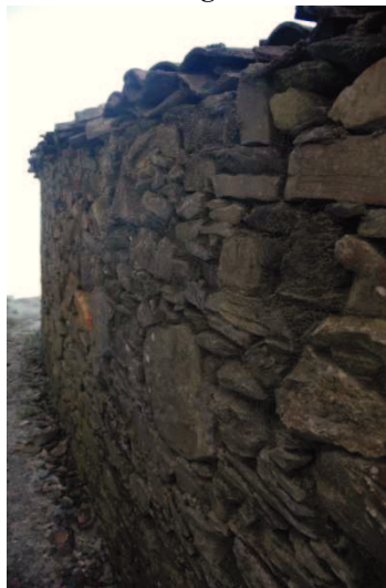
Figura 9 – Parede de alvenaria ordinária com pedra lamelar.
