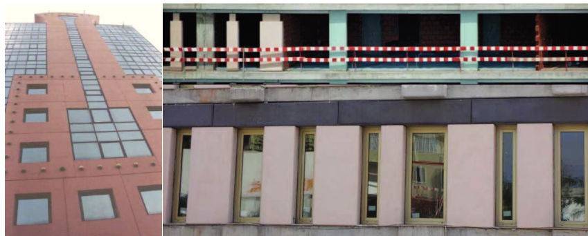
Figura 35 – Exemplos de construção com painéis pré-fabricados pesados.
