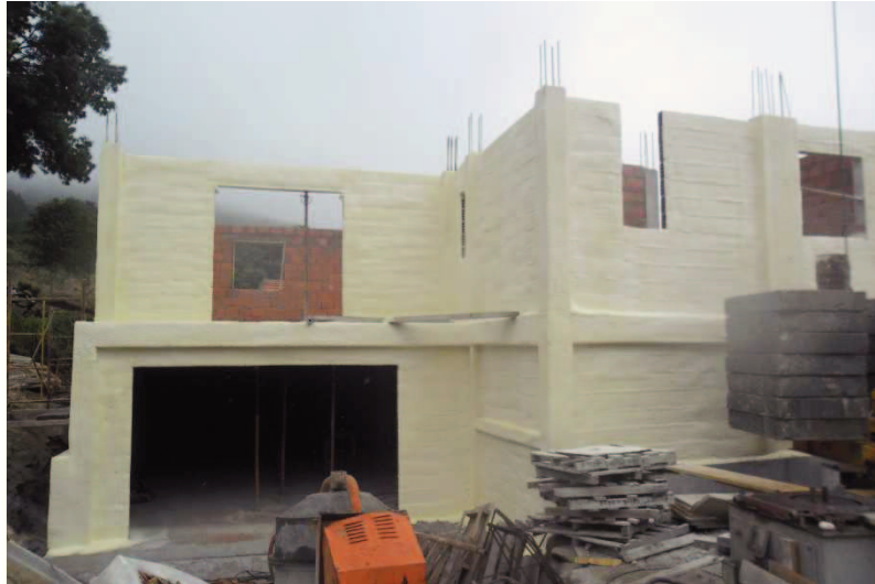
Figura 26 – Revestimento com poliuretano projectado.
