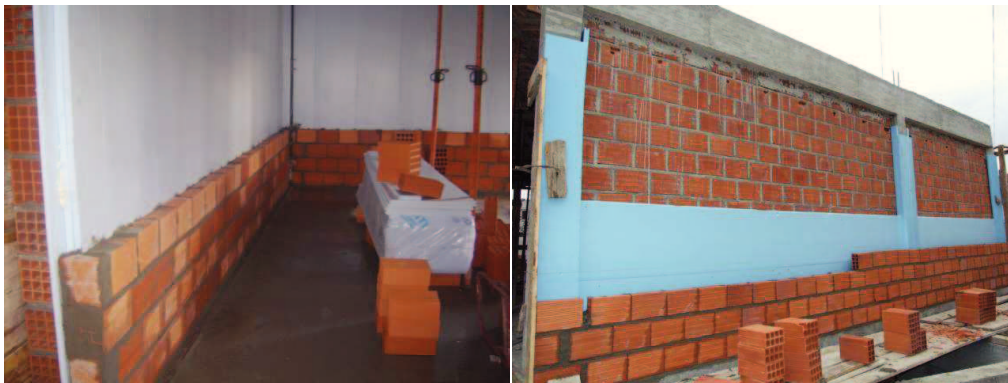
Figura 29 - Imagens de paredes de alvenaria dupla com poliestireno expandido e extrudado respectivamente.
