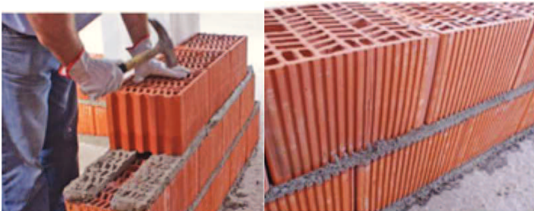
Figura 33 – Nivelamento e conclusão da fiada.
