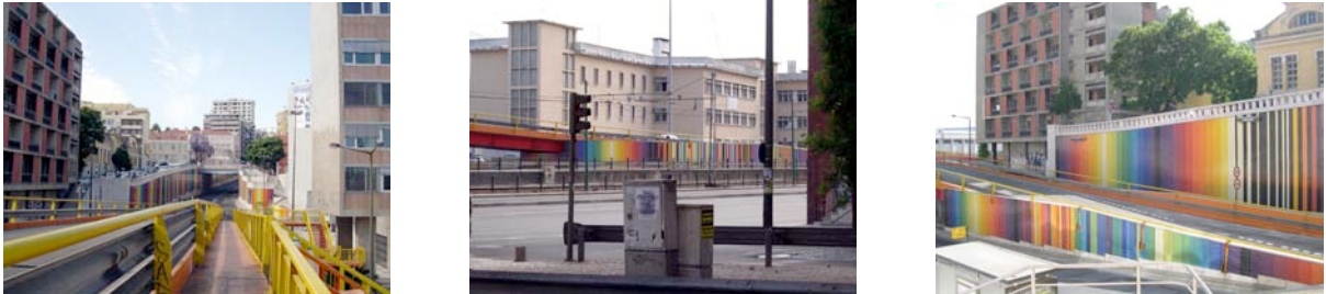
imagem 36. Destaque do revestimento, por contraste com envolvente. Viaduto da Infante Santo. Fotos da autora
