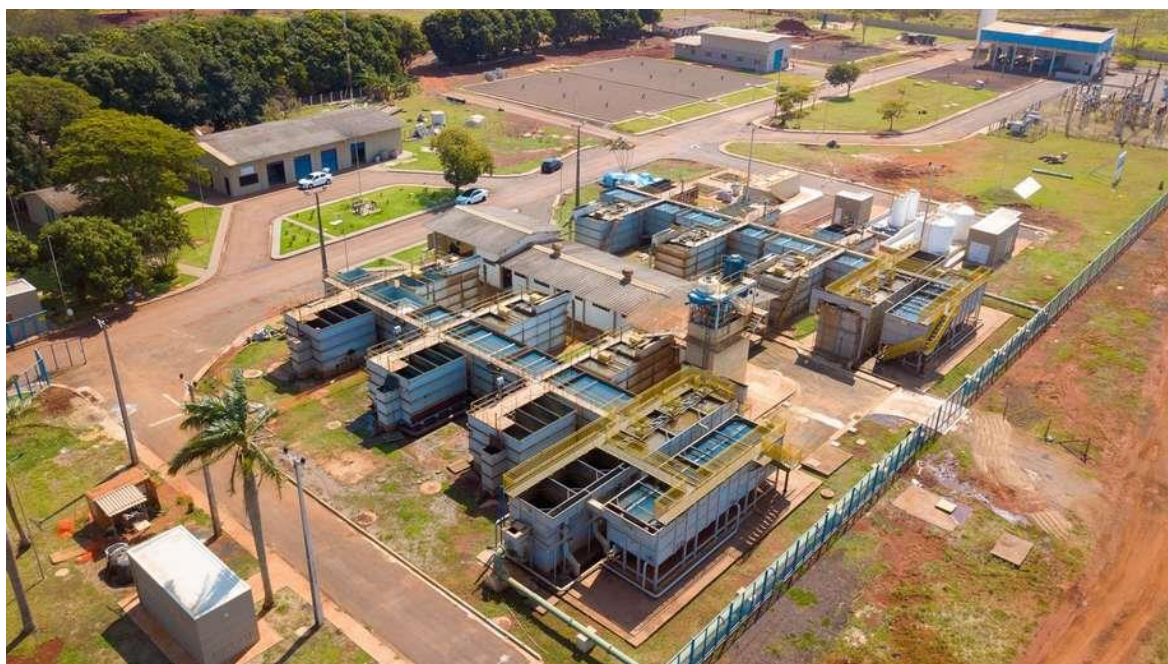
Figura 16 – Estação de Tratamento de Água Tratada do município de Dourados, Mato Grosso do Sul (SANESUL, 2020)
