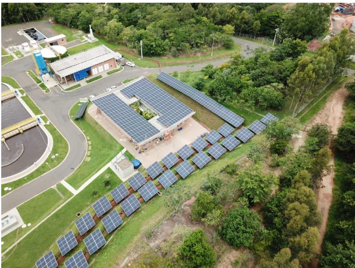
Figura 13- – Sistema de Energia Fotovoltaica na Estação de Tratamento de Águas de Mogi Mirim-SP (Sabesp, 2019)
