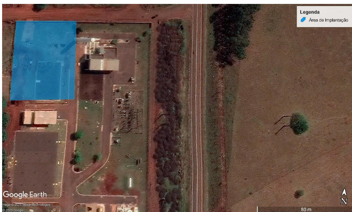
Figura 17 – Área de implantação dos painéis fotovoltaicos (Google Earth, 2020)
