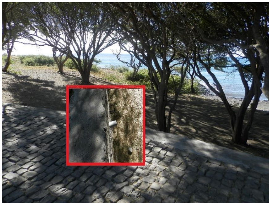
Figura 16. Descarga de fundo (Fonte: Autor)
