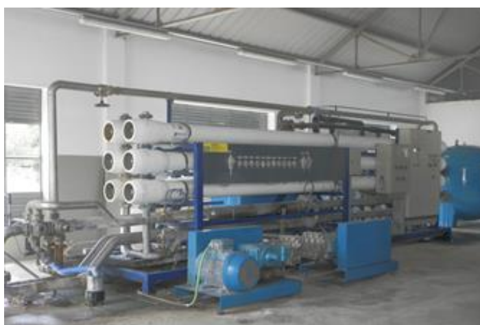
Figura 10. Unidades de RO na central de produção de água dessalinizada da APN (Fonte: Autor)
