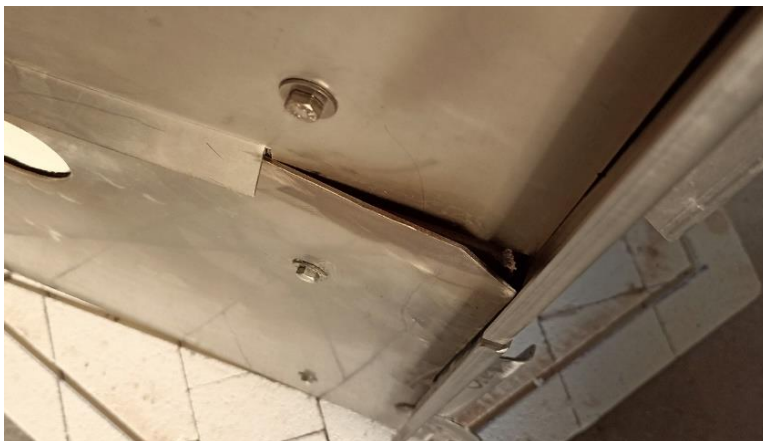
Figura 60 Pormenor da curvatura da chapa de aço.
