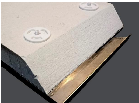
Figura 41 Pormenor do corte e colagem da placa em fibra na chapa.
