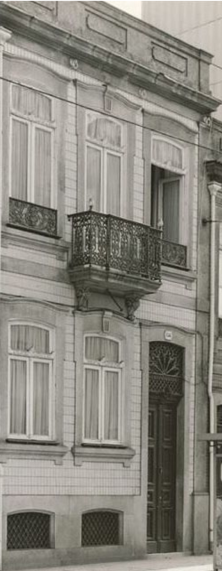
FIG. 33 | Avenida da Boavista
