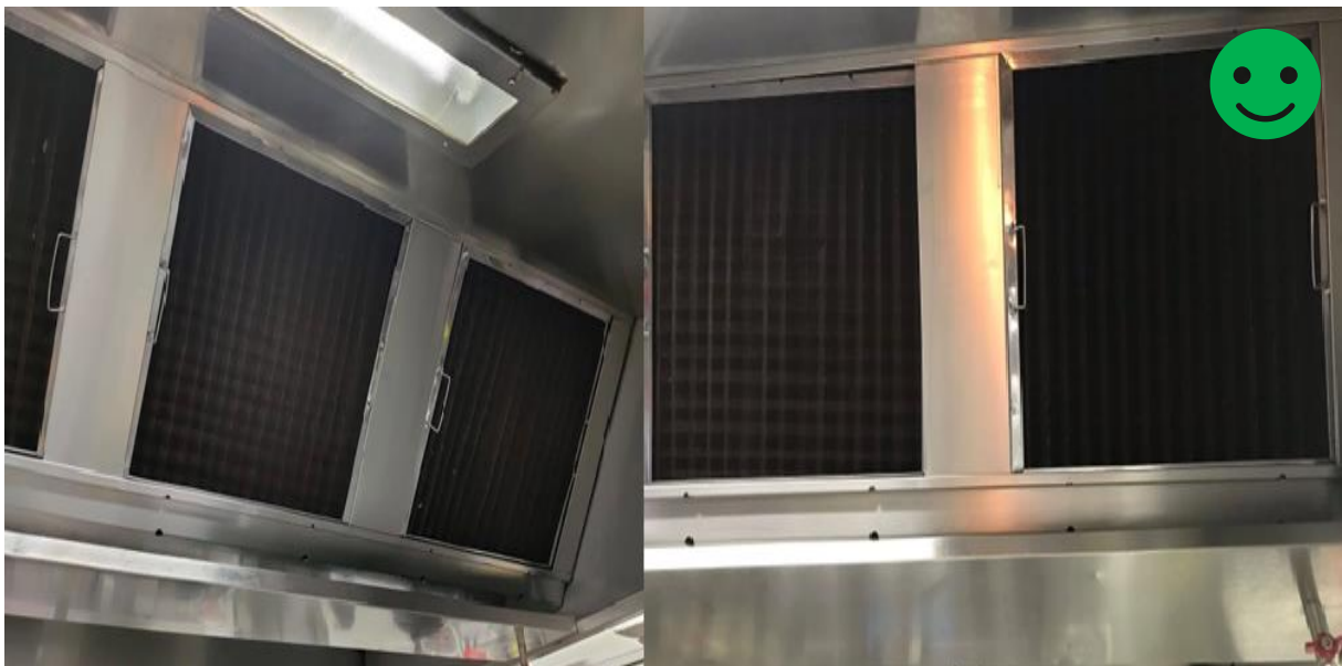
Figura 11: Exemplos de exaustores devidamente higienizados após acompanhamento. (Fonte Própria, 2022)
