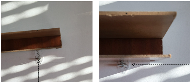
Figs. 38 e 39 Pormenor do mecanismo com a mola com os dois movimentos: descendente e ascendente.
