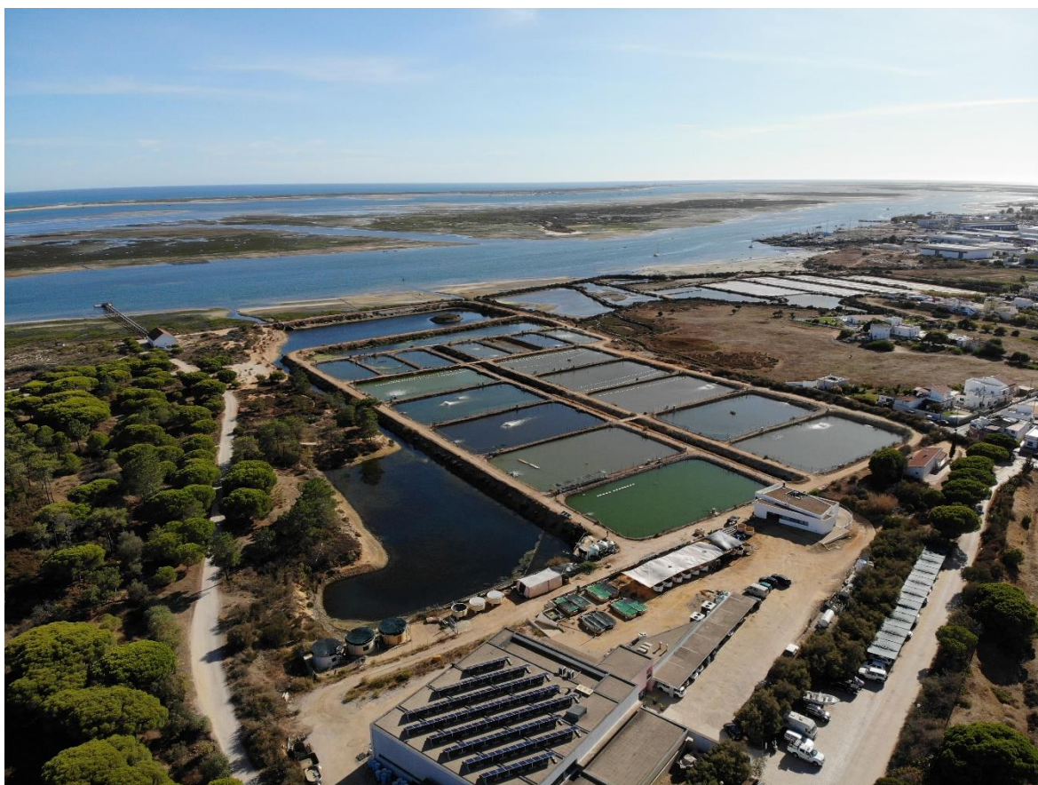
Vista aérea da Estação Piloto de Piscicultura de Olhão do IPMA onde foi realizado este trabalho.
