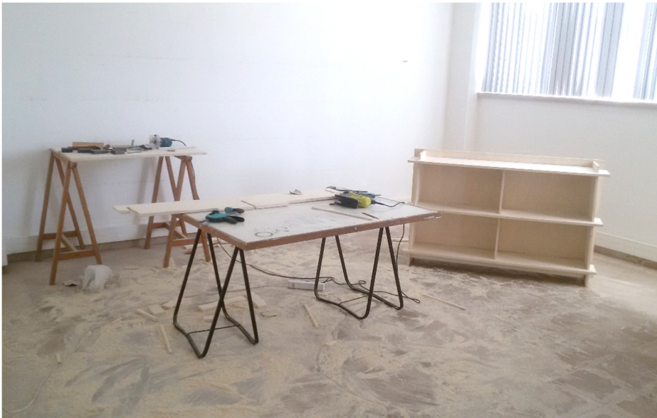
Imagem 135: Armário ‘New Order’ em execução, em oficina improvisada (08.2016) 144
