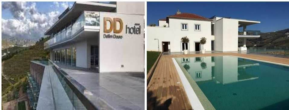
Figura 2 - Piscina Panorâmica e Receção Delfim Douro Hotel
