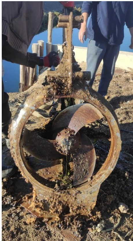
Figura 3.3- Bomba Flygt PP4650 em manutenção (imagem do próprio).
