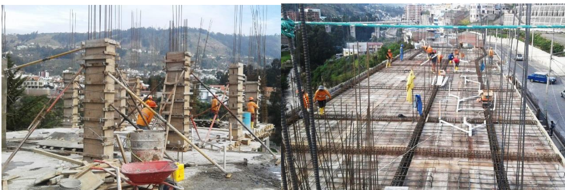
Figura 29. Estructura del edificio. Fuente: Autor
