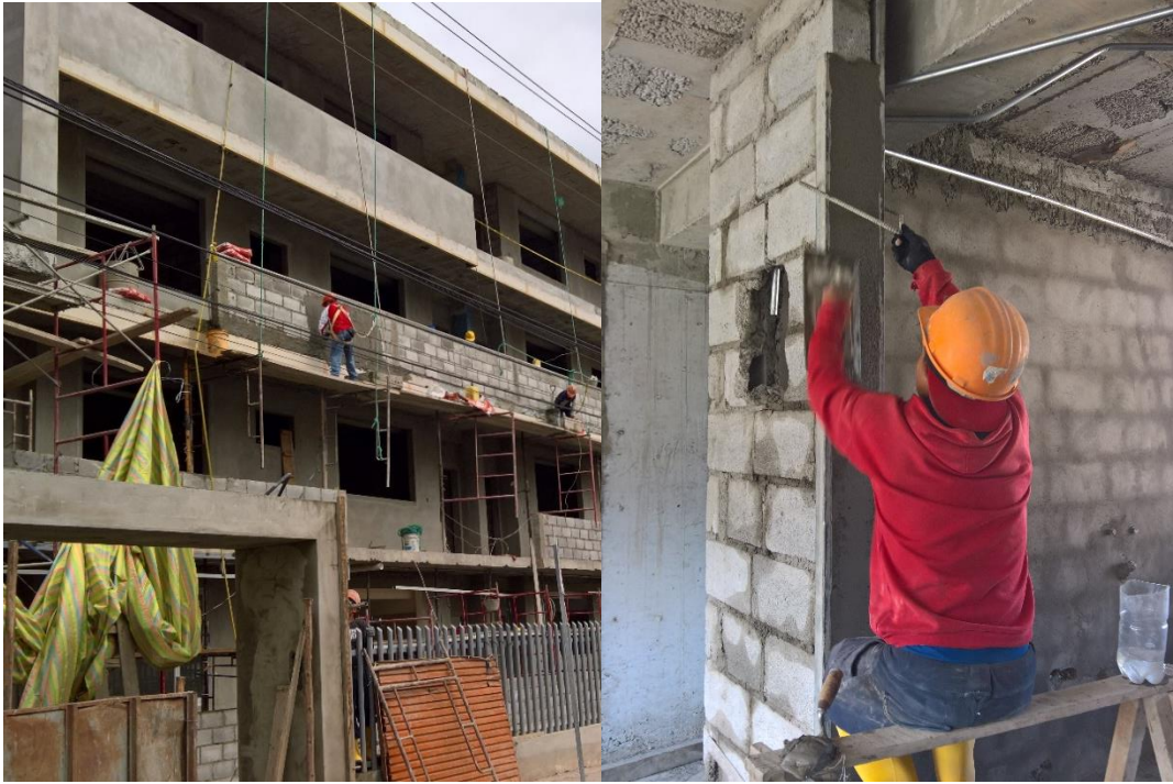
Figura 32. Enlucido de paredes. Fuente: Autor
