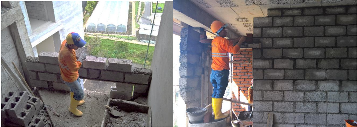
Figura 30. Colocación de mampostería. Fuente: Autor
