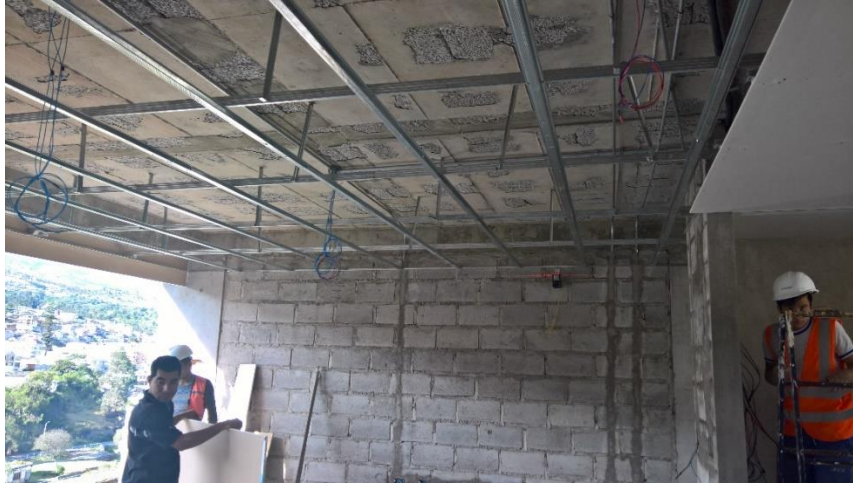
Figura 33. Colocación de techo falso. Fuente: Autor
