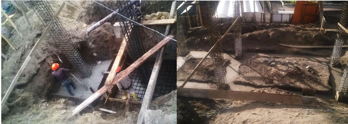
Figura 28. Cimentaciones. Fuente: Autor
