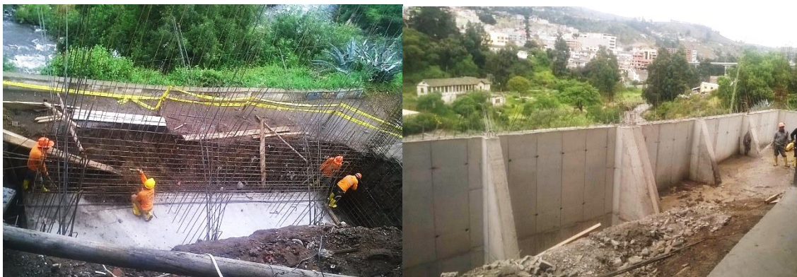
Figura 27. Elementos de contención. Fuente: Autor
