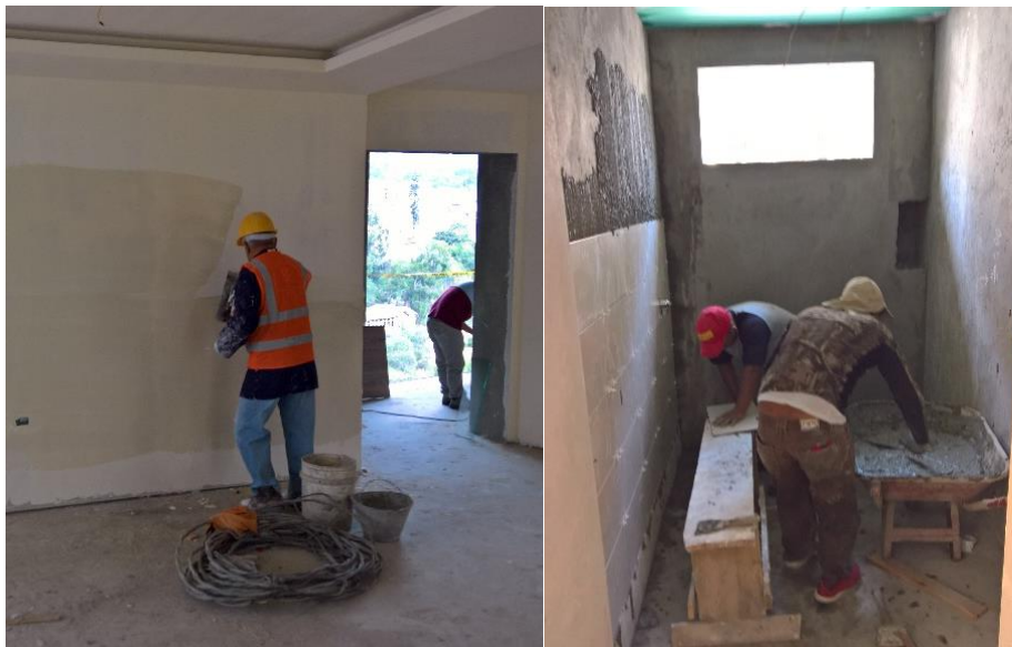
Figura 34. Revestimiento y acabado de interiores. Fuente: Autor
