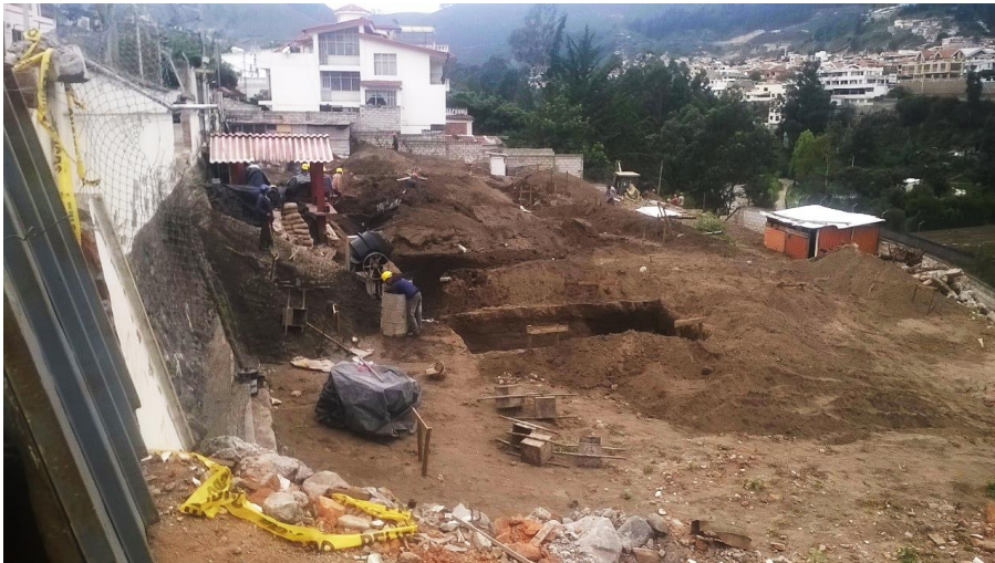
Figura 24. Trabajos Previos. Fuente: Autor
