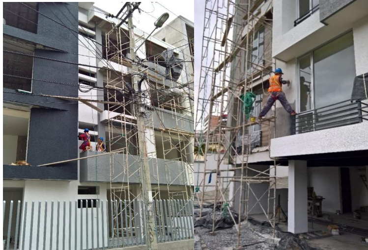
Figura 35. Revestimiento y Acabado de exteriores.
