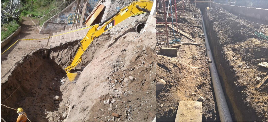
Figura 26. Movimiento de tierras. Fuente: Autor
