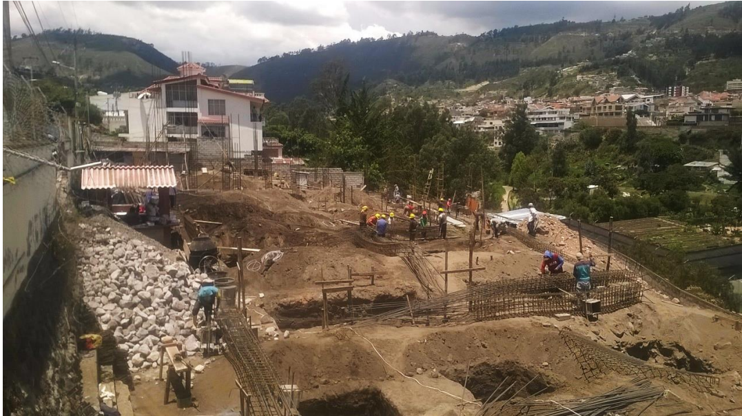
Figura 25. Replanteo de ejes principales. Fuente: Autor
