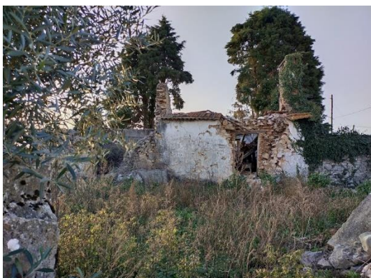
Figura 5: Perspetiva do edifício atual em ruínas (vista Este) Fonte: Própria
