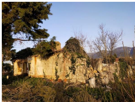
Figura 6: Perspetiva do edifício atual em ruínas (vista Oeste) Fonte: Própria
