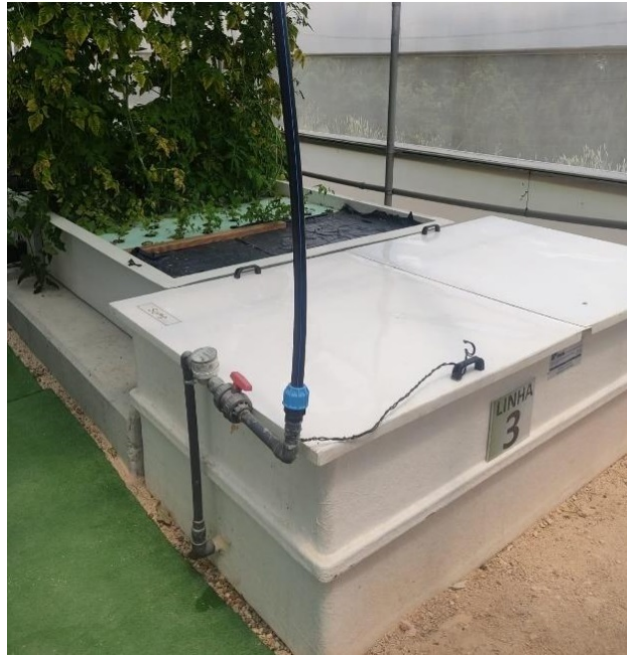
Figura 7: Sump do sistema de aquaponia monitorizado.
