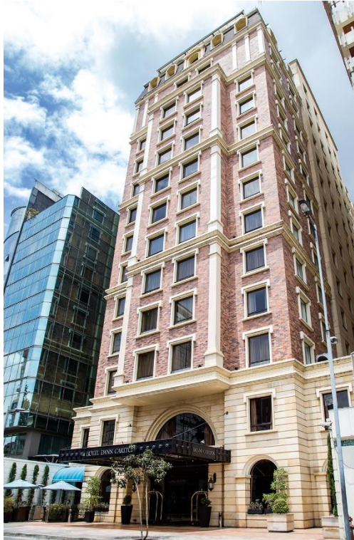
Figura 23: Vista frontal del Hotel Dann Carlton (Torre Irlanda).
