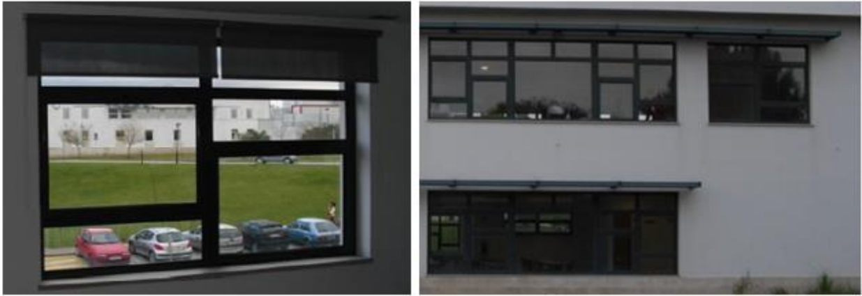
Figura 29: Cortinas (esquerda) e palas de estrutura metálica (direita) - Cantina 3.
