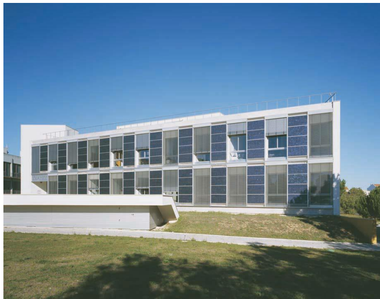
Figura 5: Fachada Sul, do edifício Solar XXI.
