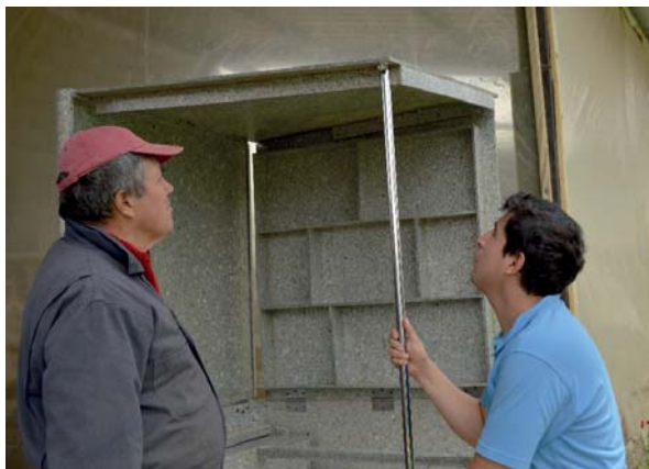
Img. 80 - 82: Colocación de refuerzos panel superior
