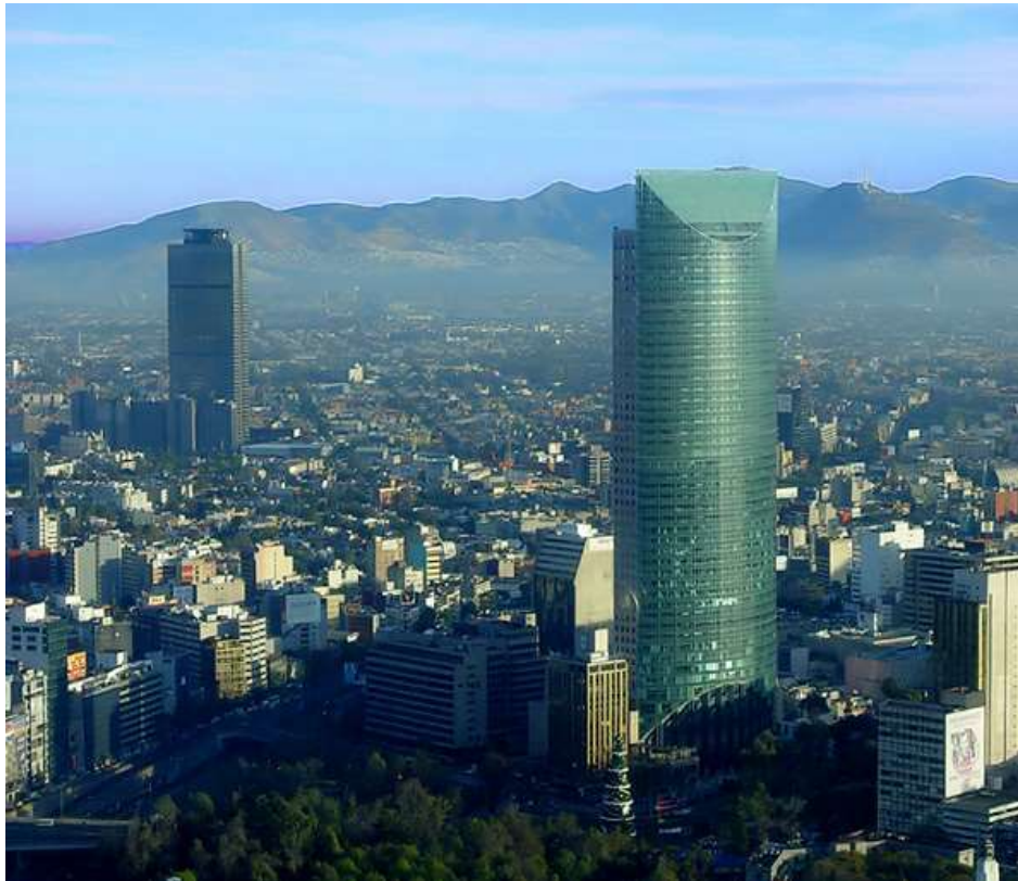
Figura 44. La Torre Mayor. Ciudad de México, México.
