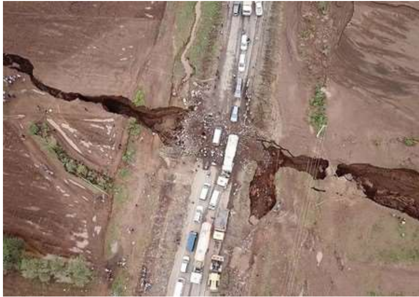
Figura 12. Grieta en el Valle del Rift de Kenia. [47]
