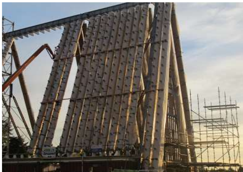
Figura 34. Estructura Principal de la Catedral de Transición constituida con tubos gigantes de cartón.
