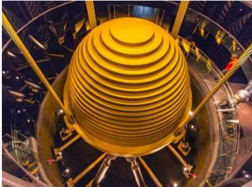
Figura 29. Amortiguador de masa utilizado en el Taipei 101.
