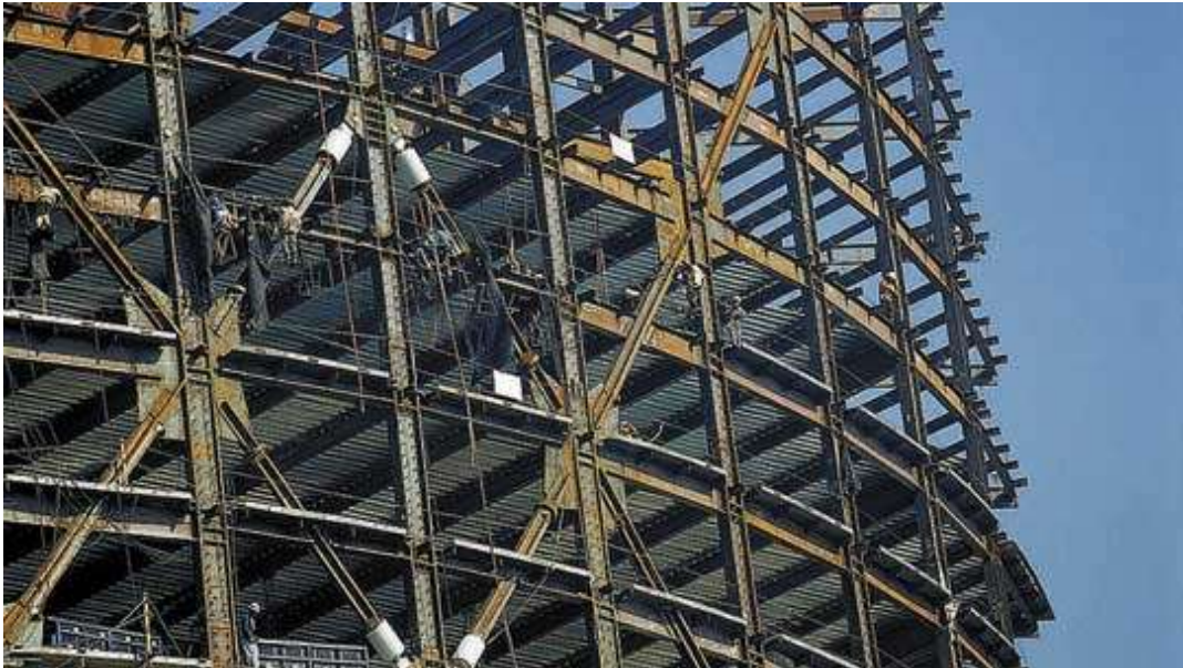
Figura 45. Sistema de amortiguadores sísmicos usados en la estructura de la Torre Mayor
