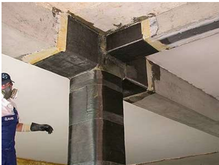
Figura 37. Refuerzo de estructuras con envolturas de FRP
