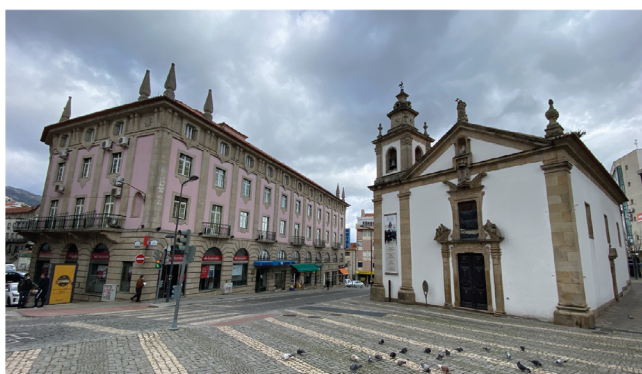
Figura 18. Registo fotográfico: Hotel Solneve e a Igreja da Misericórdia
