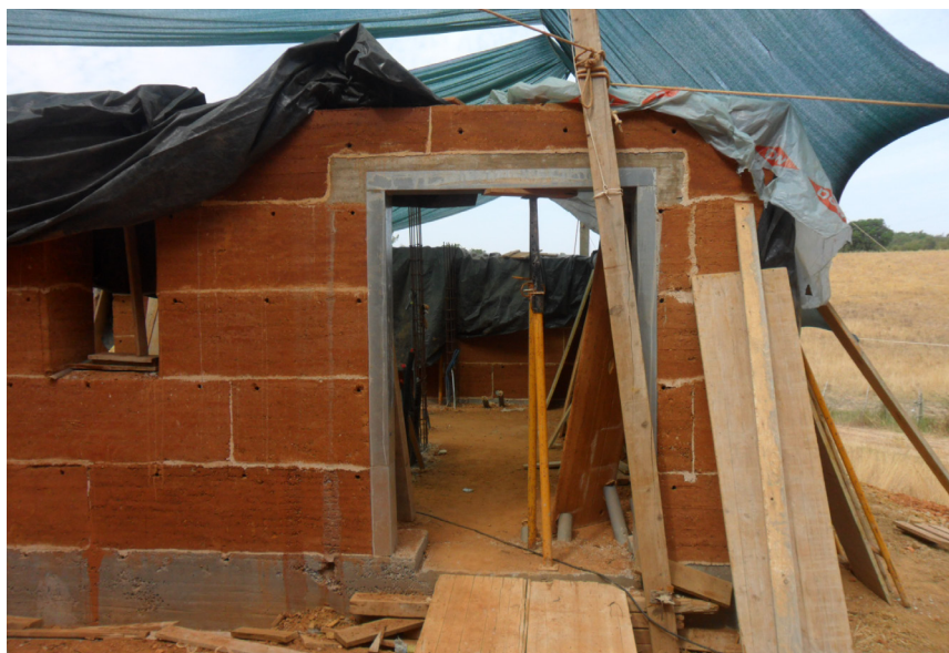
Fig. nº 32 - Vista exterior da construção
