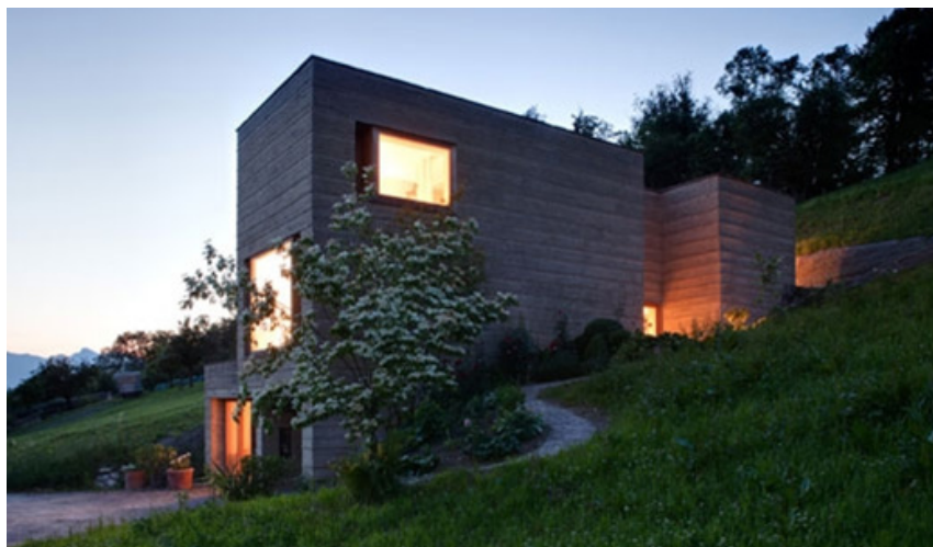
Fig. nº 1 – Casa em Schlins, Áustria
