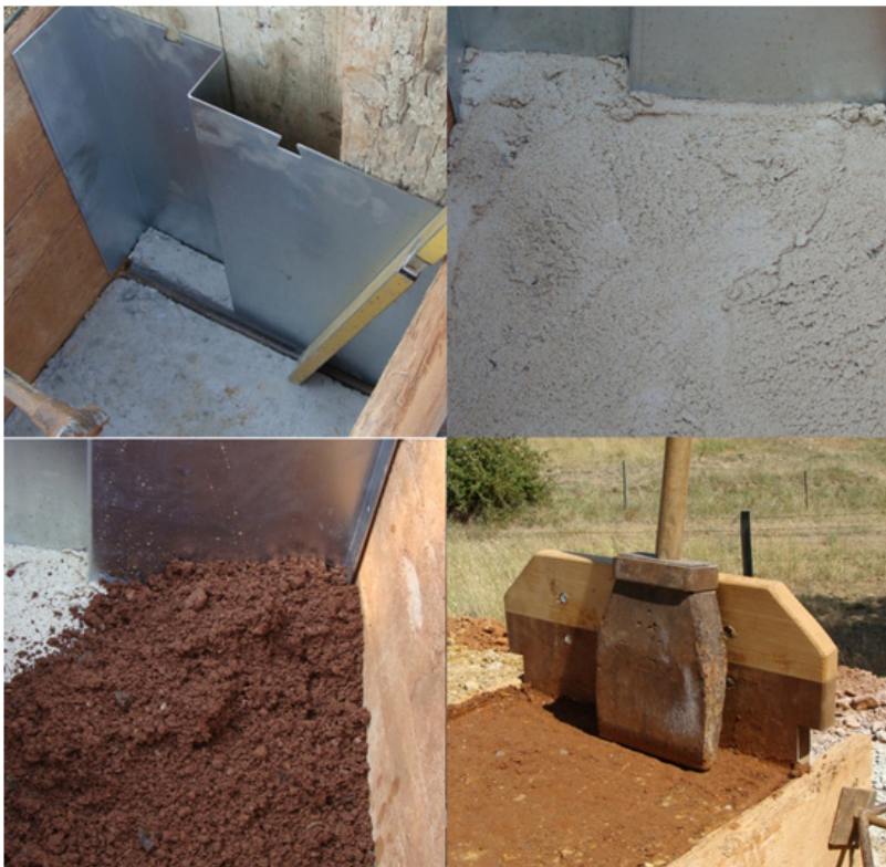
Fig. nº 31 - Preenchimento de taipal
