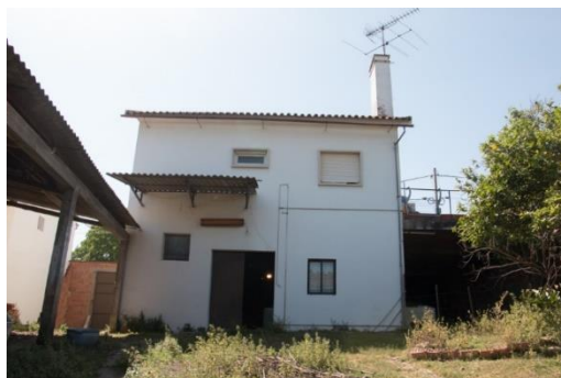
Figura A2.2 – Traseiras do edifício atual
