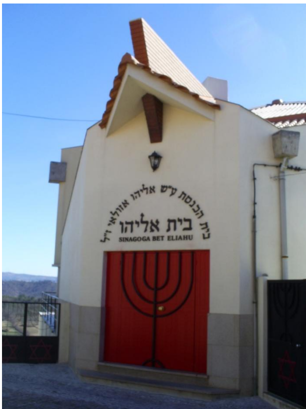
Fotografia 5 - Fachada da Sinagoga de Belmonte
