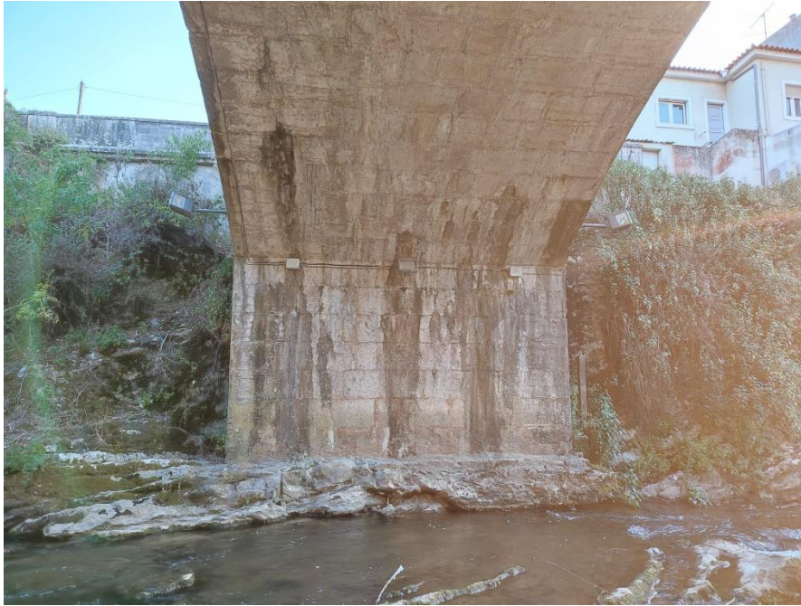
Figura 50: Pilar e Fundação – Ponte Hintze Ribeiro
