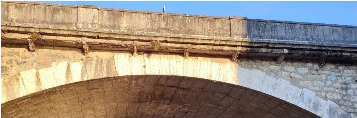
Figura 60: Vista da viga longitudinal e consolas curtas - Ponte Hintze Ribeiro
