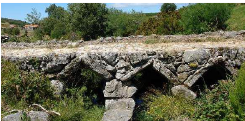
Figura 10: Ponte "Celta" de Castro Laboreiro (Vilarinho, 2020)
