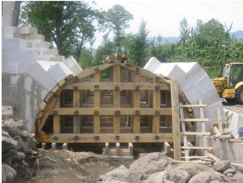
Figura 18: Cimbramento da ponte de Vila Fria. (P. Costa, 2007)
