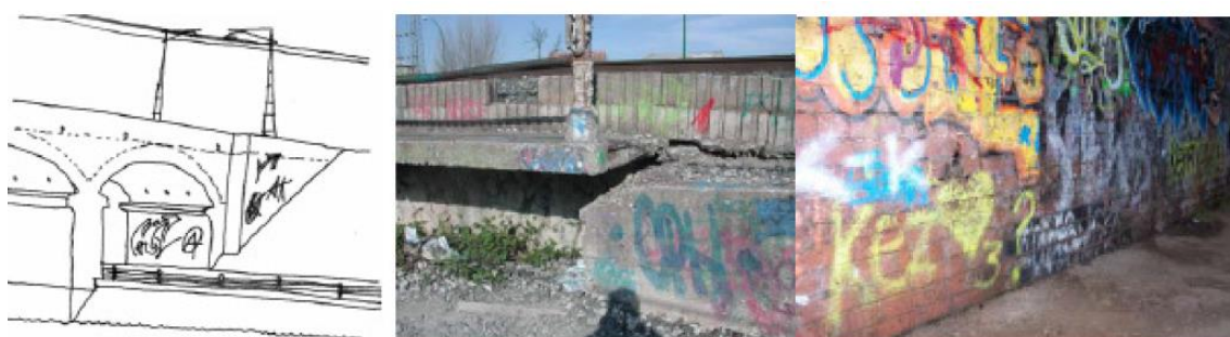
Figura 44: Exemplos de danos resultantes da ação humana (Catalán e Álamo, 2006, apud Lopes, 2012)
