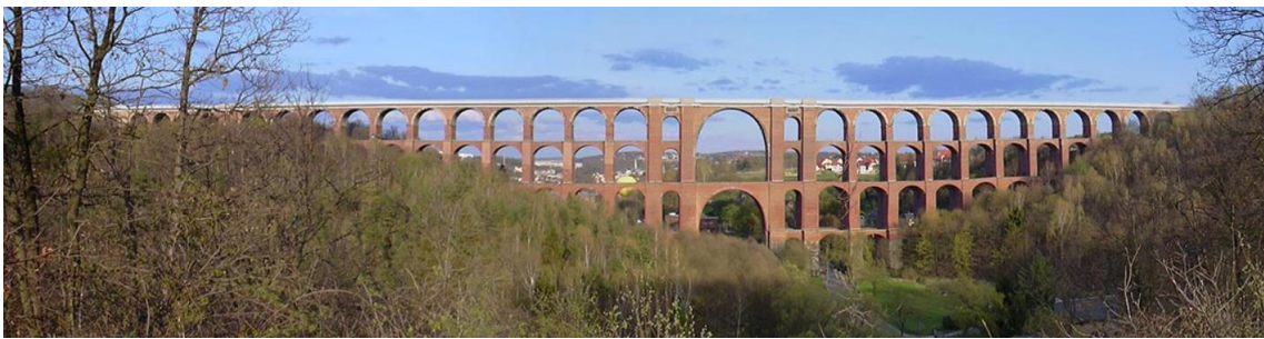
Figura 5: Ponte Göltzschtalbrücke – Alemanha (Wikipedia)
