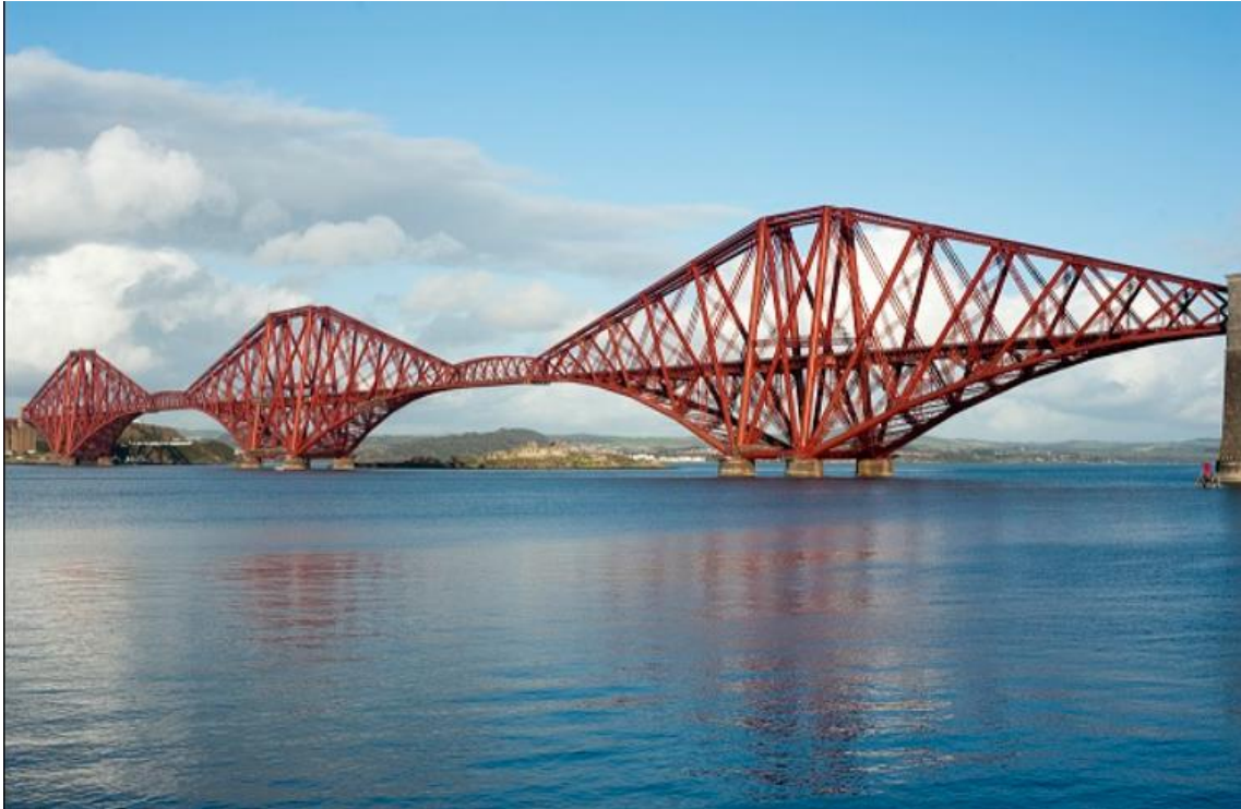
Figura 6: Ponte Firth of Forth – Escócia ( http://desciclo.pedia.ws/wiki/Ponte_do_Forth#/media/Arquivo:Forth_Bridge.jpg )
