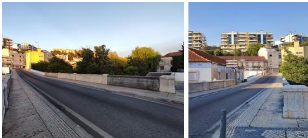
Figura 58: Pavimento betuminoso reparado – Ponte Hintze Ribeiro
