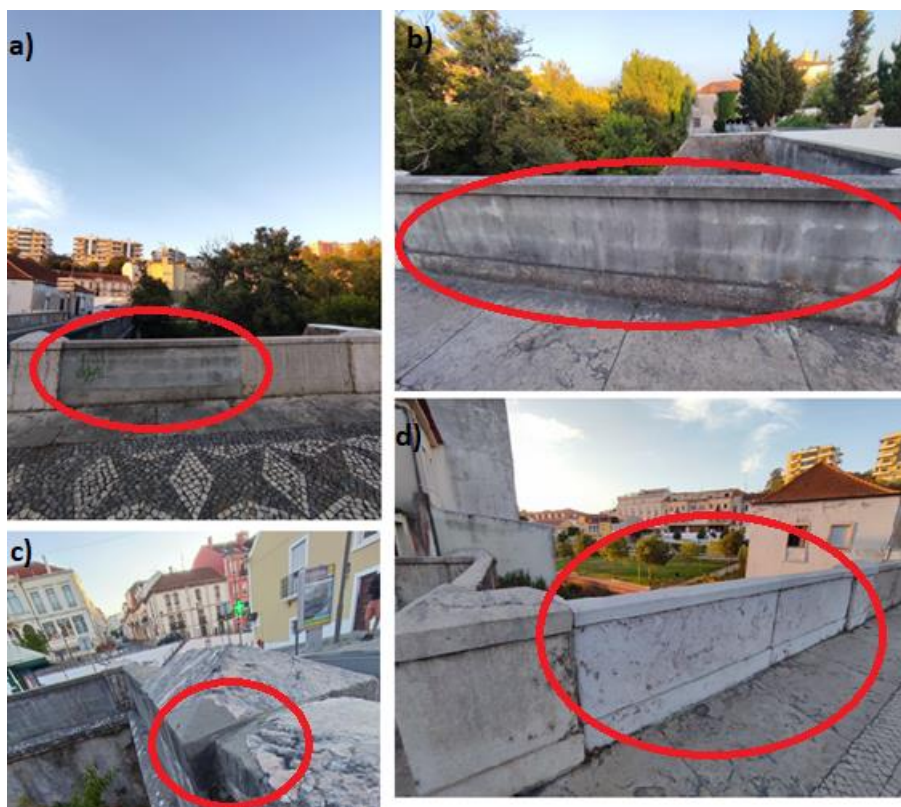
Figura 69: Guarda-corpos reparados – a) e b) substituição por muro de blocos de betão com reboco de argamassa, c) reparo pontual com argamassa, d) substituição por pedra do mesmo tipo das originais - Ponte Hintze Ribeiro
