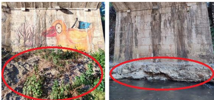
Figura 67: Fundações - Ponte Hintze Ribeiro – (Autor, 2022)
