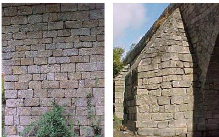
Figura 43: Exemplo de perda de argamassa nas juntas (Costa, 2002)
