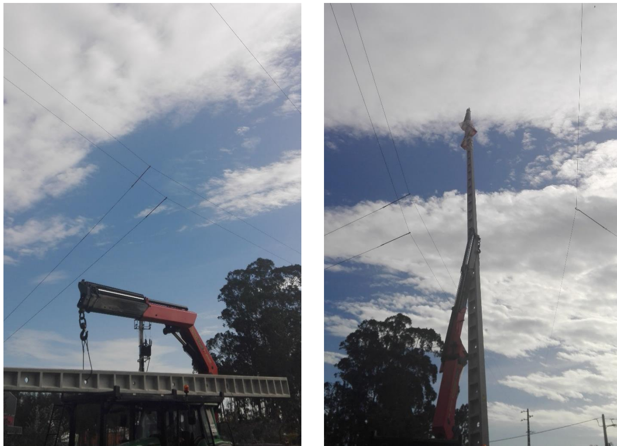
Figura 7 - Montagem do Apoio.
