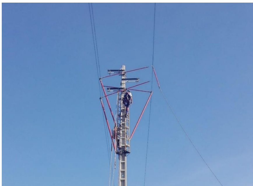
Figura 10 - Fixação dos Condutores com Varas Isoladoras.
