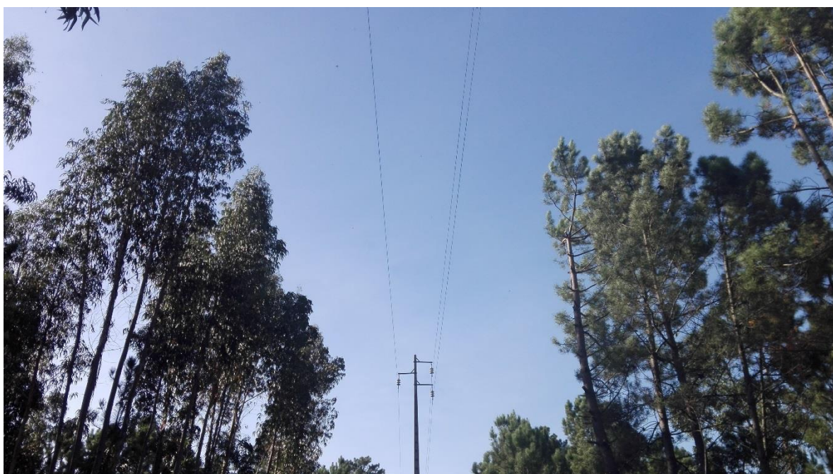
Figura 4 - Distância das Linhas à Vegetação Após Corte.
