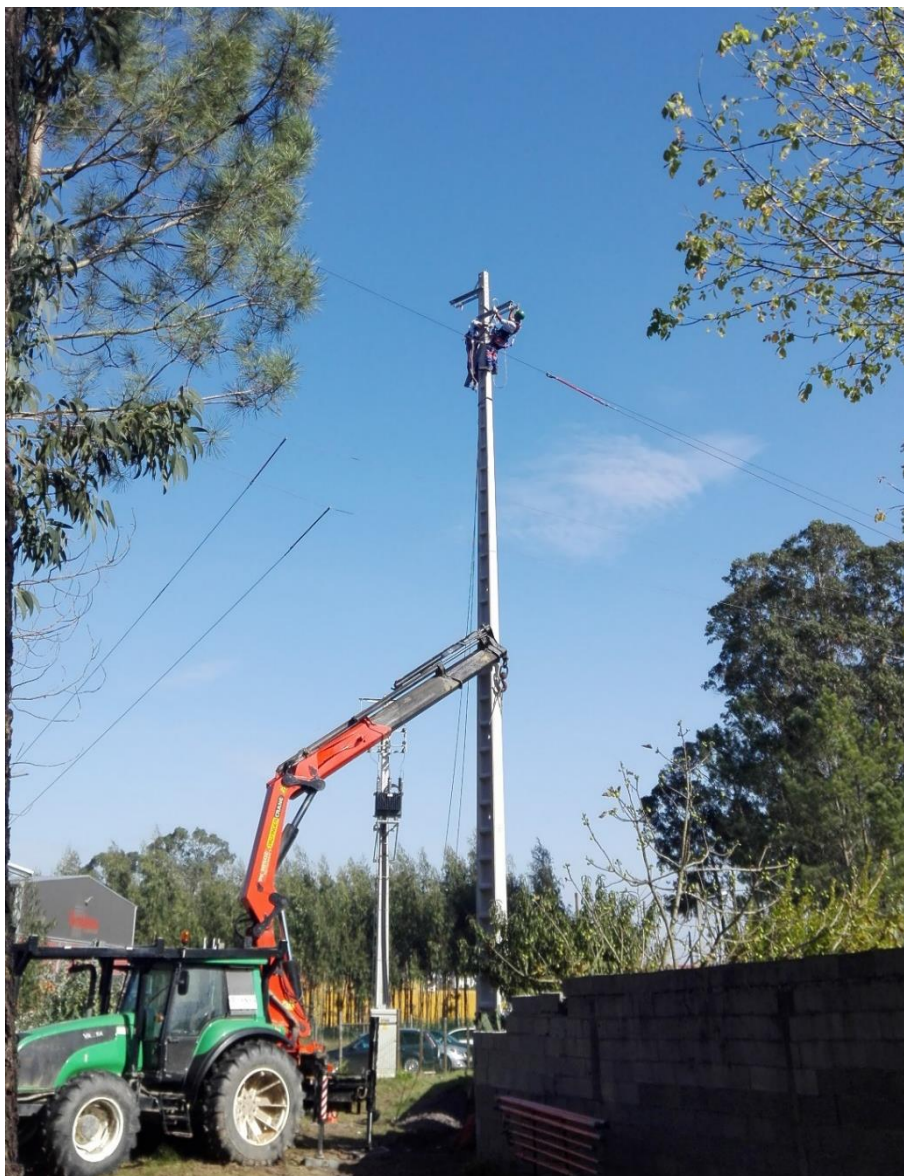
Figura 9 - Colocação da Armação no Apoio.
