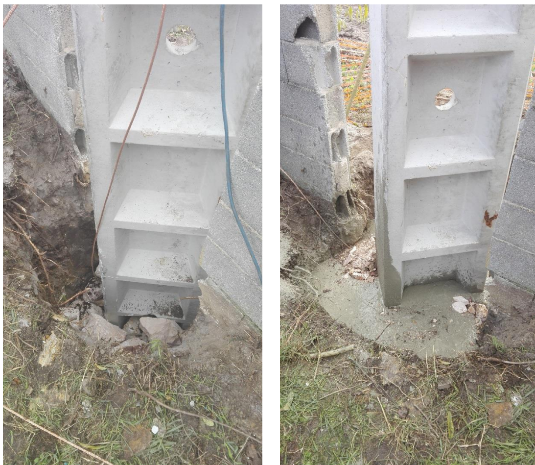
Figura 8 - Fixação do Apoio ao Solo.
