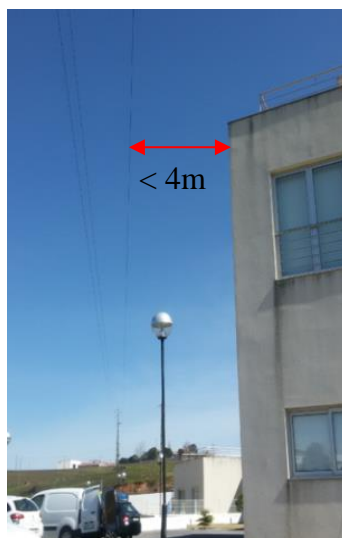
Figura 5-4 - Proximidade da Linha à Construção.
