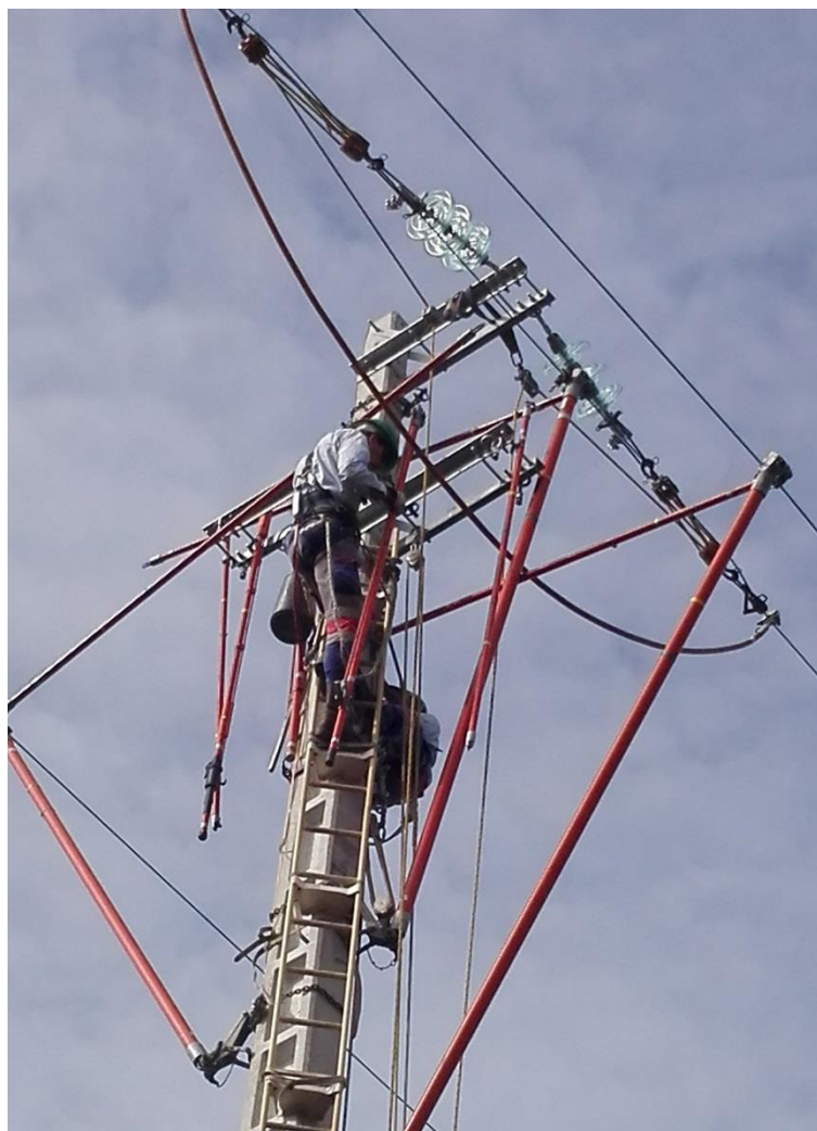
Figura 12 - Colocação das Cadeia de Isoladores.
