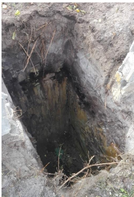
Figura 2 - Fundação do Apoio.
