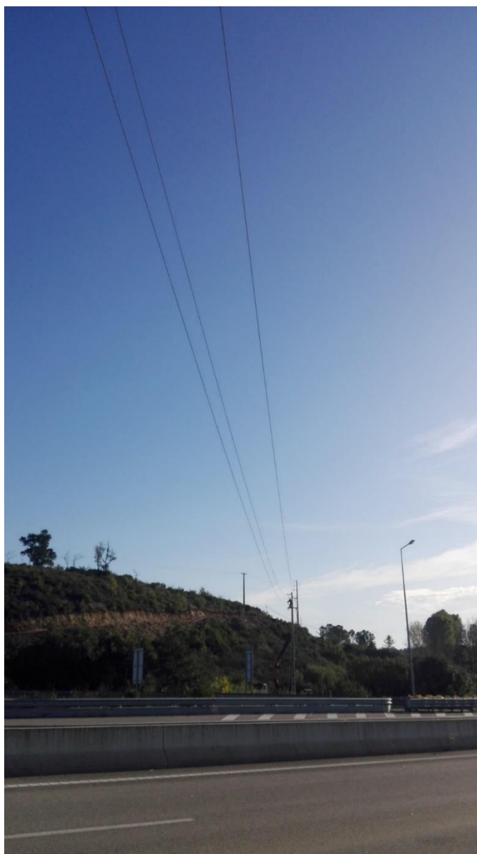
Figura 6 - Condutores a Retirar.
