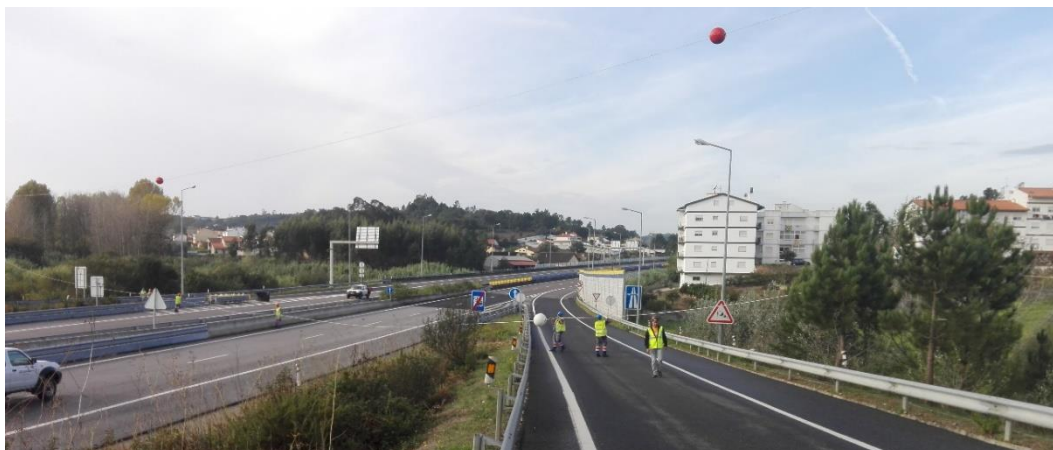
Figura 8 - Colocação Condutores (1).
