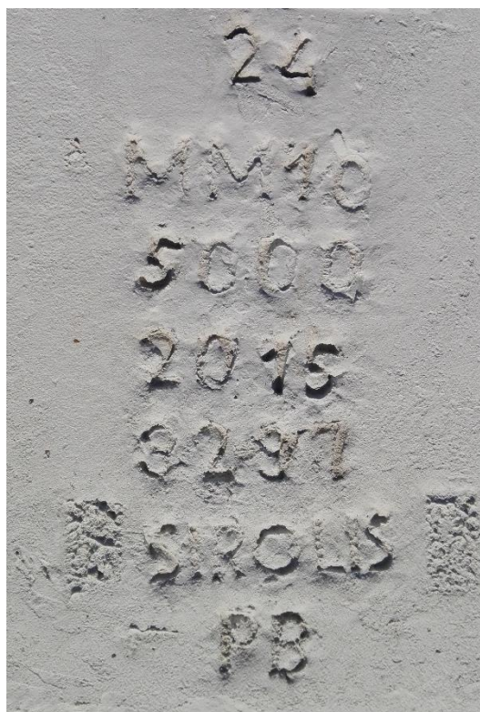
Figura 2 - Características dos Apoios Instalados.
