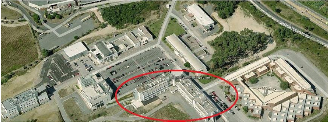
Figura 3.5 – Vista aérea do campus 2, com identificação da localização do edifício D.
