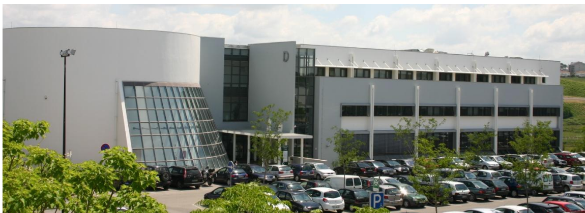
Figura 3.6 – Vista exterior do edifício D do campus 2.
