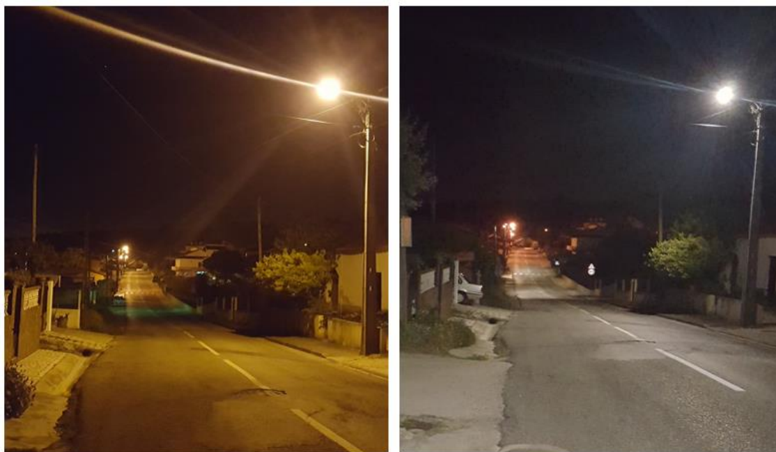
Figura 4-11 - Rua Principal de Pernelhas Antes (Esq.) e Depois (Dta) de Colocação de LEDs
