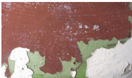
Imagem 24 - Exemplo de uma parede exterior
