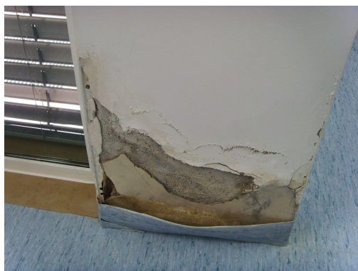
Figura 14- Revestimento de pilar em betão armado.
