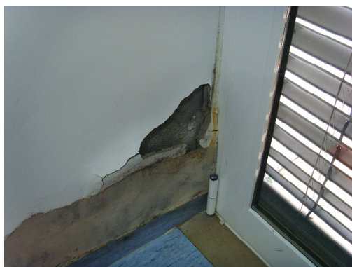
Figura 11- Face interior da parede em betão armado
