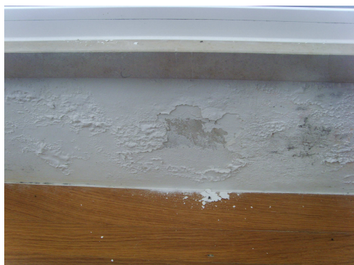
Figura 25- Parede em betão da figura 23 com o banco de madeira aplicado
