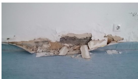
Figura 30- Parede interior em betão armado, de encosto, algum tempo após a reparação – leitura 10
