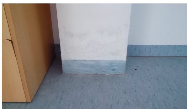
Figura 16- Pilar a meio da sala polivalente
