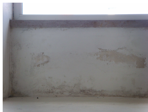
Figura 24- Parede em betão
