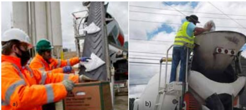
Figura 10: a) Adição de fibra semi-automatizada. b) adição de fibra manualmente[24]
