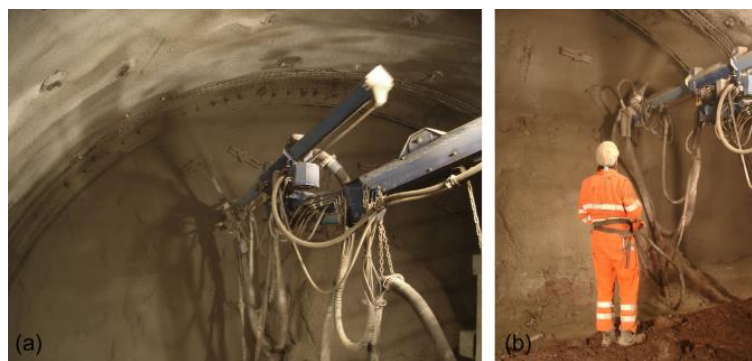
Figura 3: Aplicação do betão projetado por processo de mistura úmida em túneis (a, b)[16]
