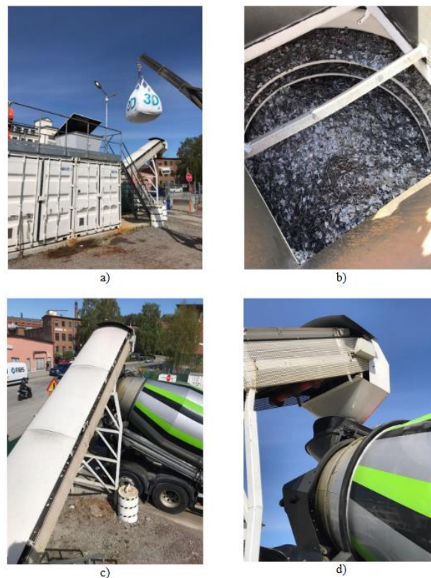
Figura 9: Entrega de Betão Reforçado com Fibra de Aço. Betongindustri AB, Estocolmo[23]
