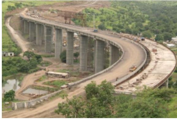
Figura 4: Aplicação de SFRC na construção do ponte rodoviário (uso de lajes pré-fabricados)[17]
