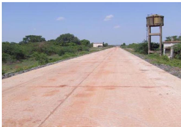
Figura 6: Aplicação do SFRC na construção de estrada (lajes pré-fabricados)[18]
