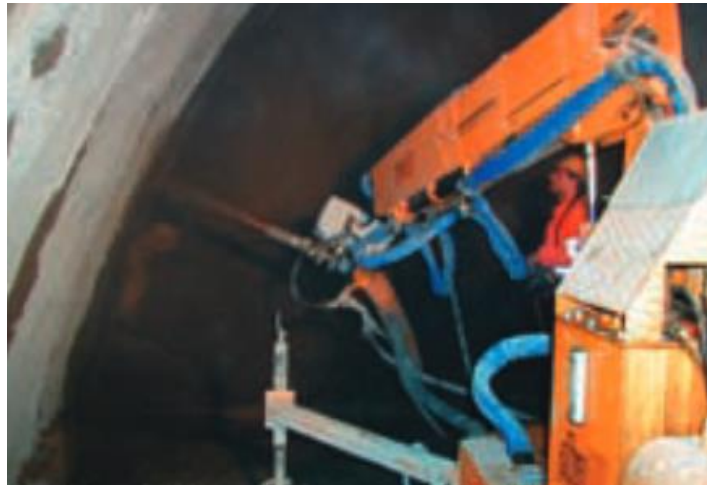
Figura 1: Aplicação de mistura húmida de modo automatizado[6]
