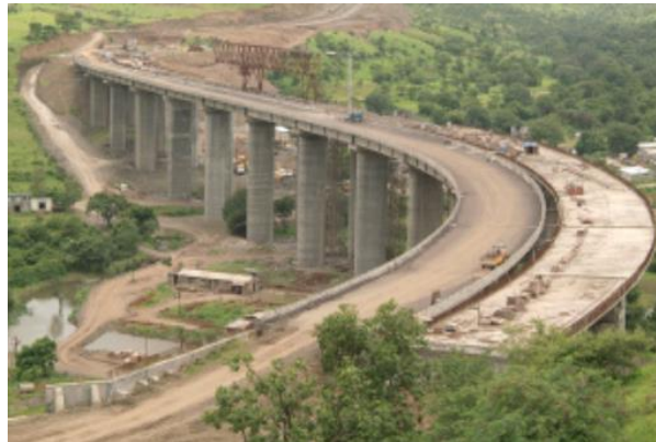
Figura 5: Aplicação de SFRC na construção do ponte rodoviário (uso de lajes pré-fabricados)[17]
