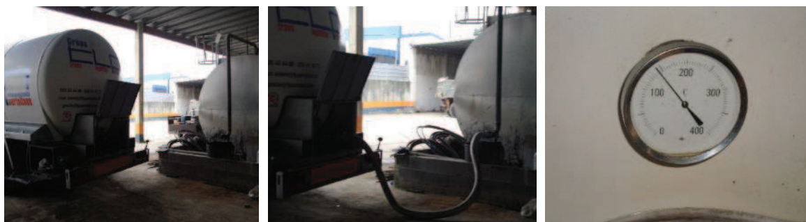
Figura 71 - Descarga do betume para a cisterna da empresa "Cimalha" a 150 °C aproximadamente
