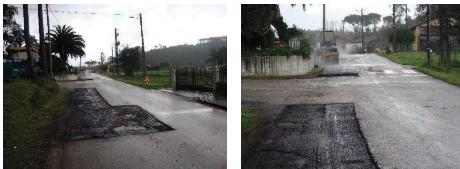
Figura 86 - Trecho da estrada após aplicação da rega “cola” (Souto da Carpalhosa)
