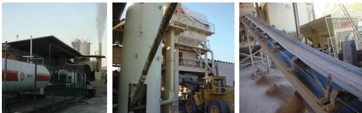
Figura 78 - Central descontínua da “Cimalha” em funcionamento, esteira transportadora de inertes
