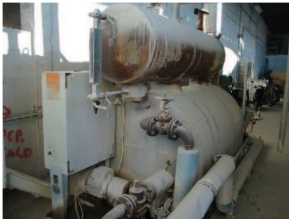
Figura 9 - Cisterna, depósito de óleo
