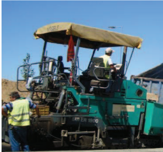
Figura 87 – Comboio entre o camião e a pavimentadora
