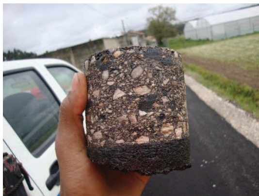
Figura 94 - Carote com a separação das camadas, pavimento recente
