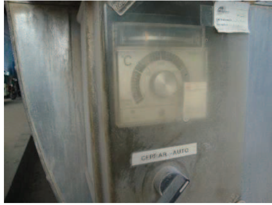
Figura 8 - Temperatura de saída do betume da cisterna, estado líquido (acima dos 100 °C)
