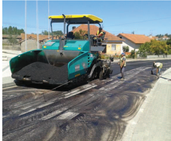
Figura 88 – Pavimentação de trecho da estrada
