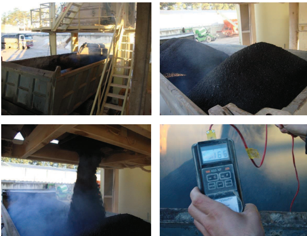
Figura 80 - Descarga direta da mistura e controlo da temperatura "Cimalha" (165 °C)
