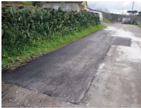
Figura 90 - Treco do pavimento reabilitado "Cimalha" (Souto da Carpalhosa)
