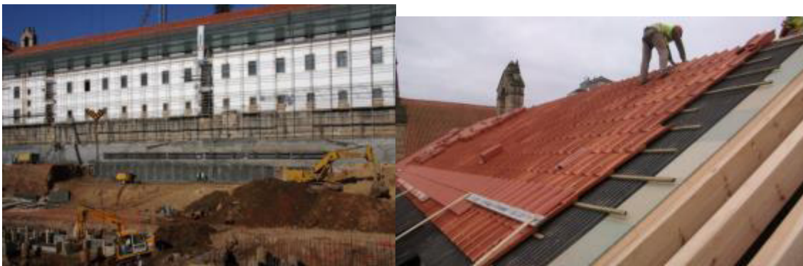
Figura 12: Fotos da Reabilitação do Convento de São Francisco – Coimbra
