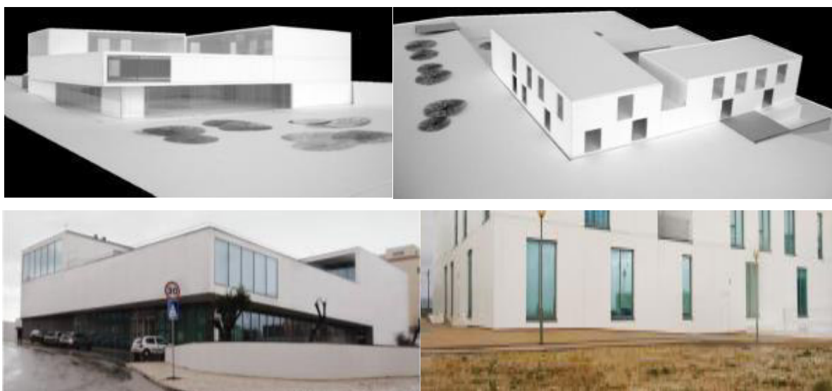
Figura 19: Fotos do projeto e da execução da obra
