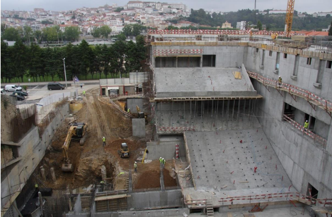
Figura 31: Trabalhos em Betão Armado na obra do Convento de São Francisco
