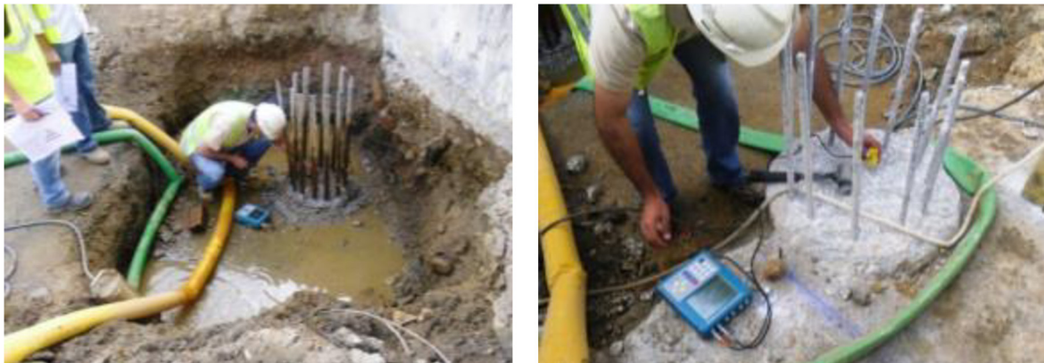
Figura 46: Execução de Ensaio Sísmico
