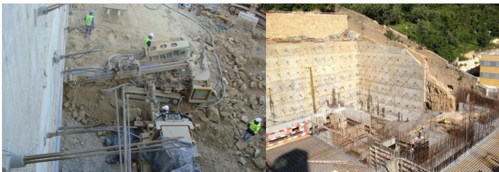
Figura 52: Exemplo de Furação na obra do Convento de São Francisco
