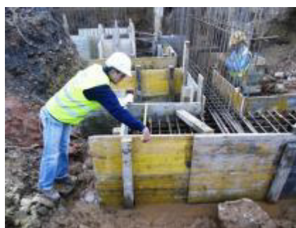
Figura 37: Verificação das armaduras em obra
