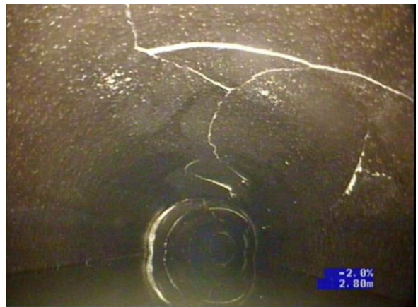
Figura 75 - Fissuras graves
