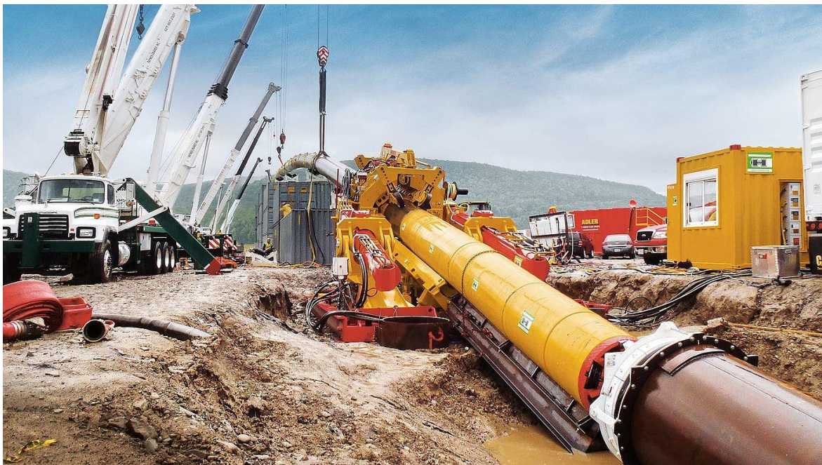
Figura 3 - Poço de partida. (6)
