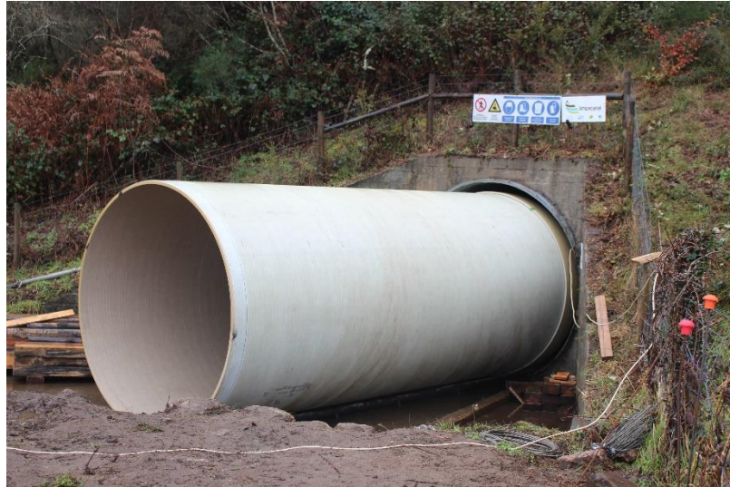
Figura 42 – Tubos sobre carril guia à boca da PH (5)
