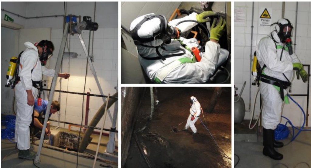
Figura 64 – Exemplos de trabalhos em espaços confinados com atmosferas tóxicas (5)
