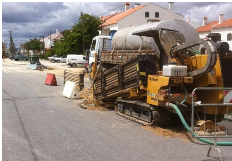
Figura 1 - Equipamento de Perfuração (4)
