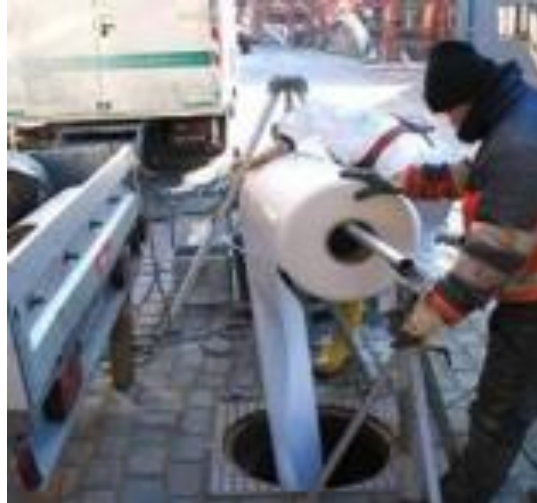
Figura 26 –Aplicação da folha protetora (5)
