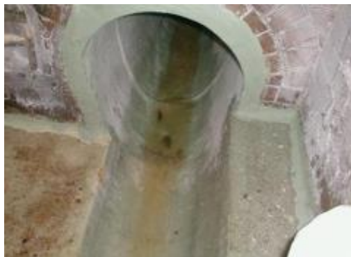
Figura 31 – Acabamento da manga em caixas de visita (5)
