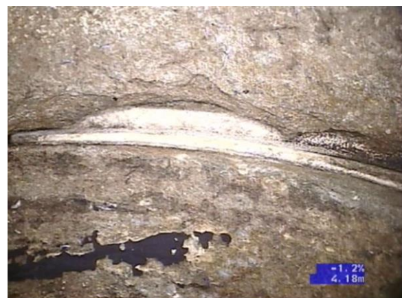
Figura 69 - Faltam seções na junta (HPC2)
