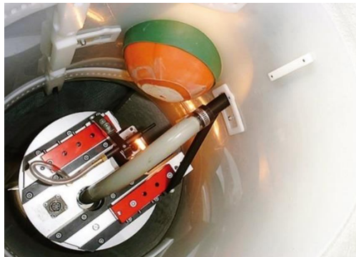
Figura 58 - Injeção de argamassa para selagem de ramais (5)
