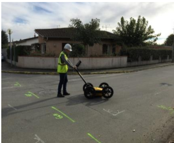
Figura 4 - Detecção de infraestruturas enterradas com Georadar (5)
