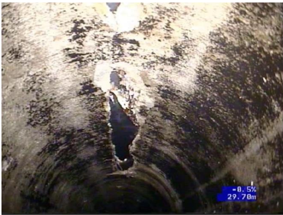
Figura 72 - Faltam secções (HPC3)
