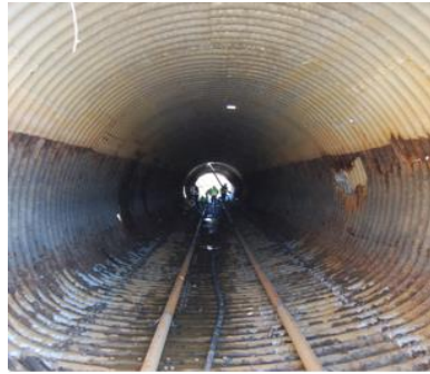
Figura 40 – Colocação de carril guia (5)
