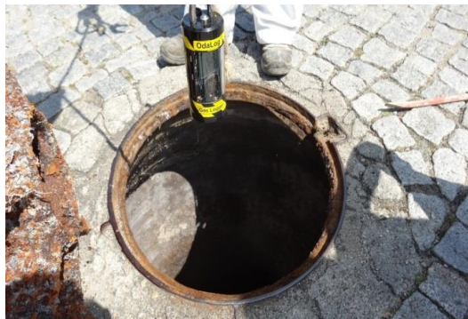
Figura 53 - Equipamento de medição de H 2 S (5)
