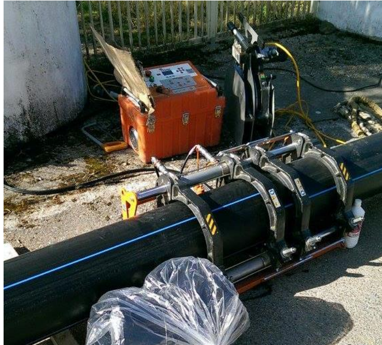
Figura 2 - Soldadura topo-a-topo de tubo de PEAD (5)
