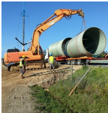
Figura 41 – Descarga de tubos em obra (5)
