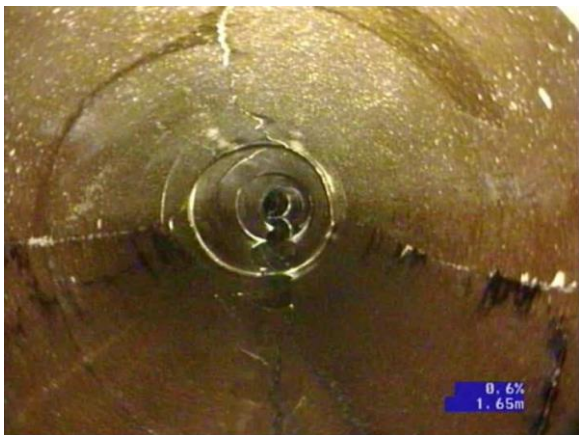
Figura 74 - Fissuras reticulares
