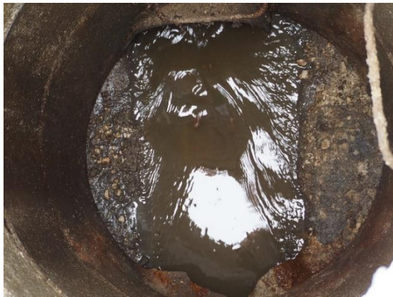
Figura 81 - Fundo degradado
