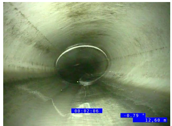
Figura 78 - Imagens de deformações acentuadas
