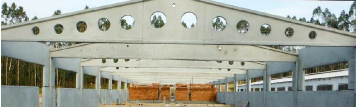
Figura 3: Asnas em betão instalada na obra. (Fonte: Catálogo SEP Sancho)
