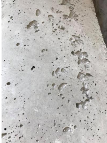
Figura 21: Crateras na superfície de uma asna.
