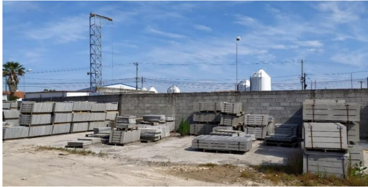
Figura 25: Estaleiro de armazenagem de produtos acabados.
