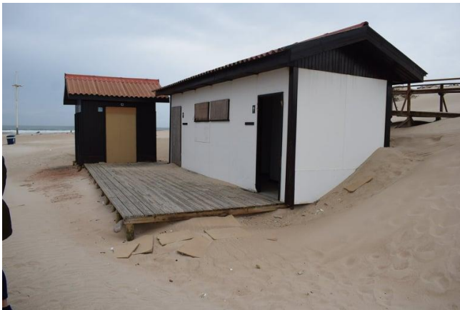
Figura 19: WC e WC para pessoas com mobilidade reduzida, Praia Baleal Sul.
