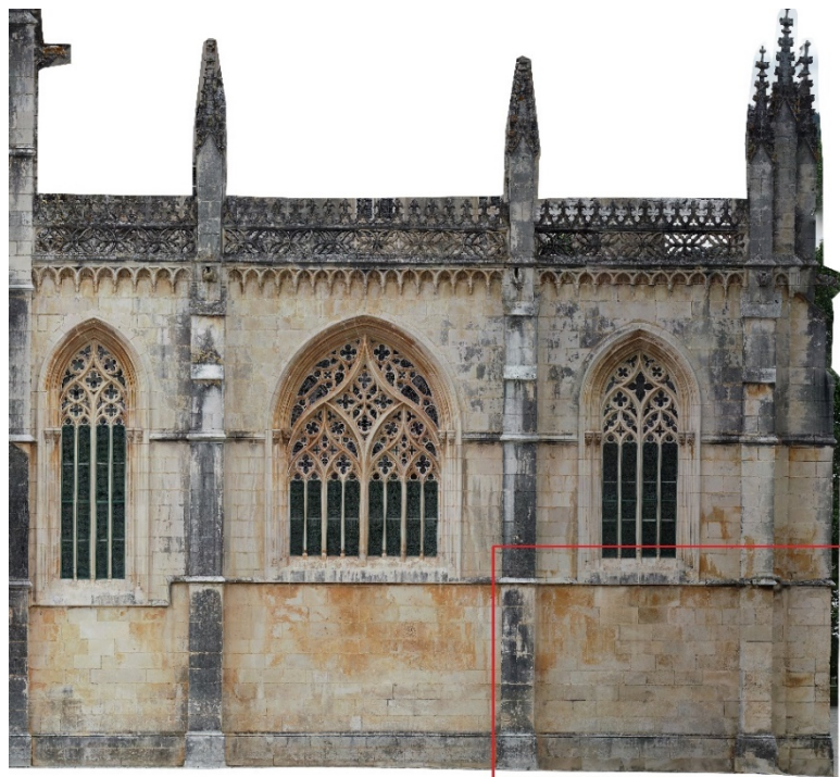
Figura 5.23 –Área de estudo Termografia
