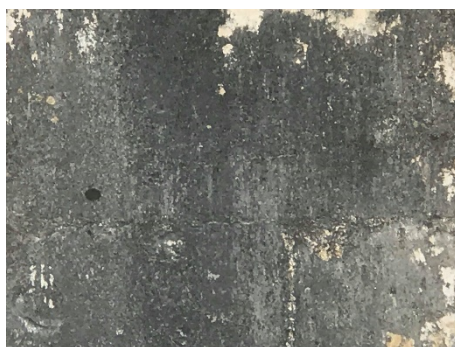
Figura 3.2 – Exemplo de Crosta Negra
