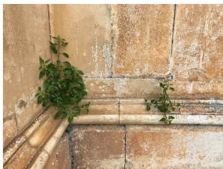
Figura 3.5 – Exemplo de Colonização Biológica
