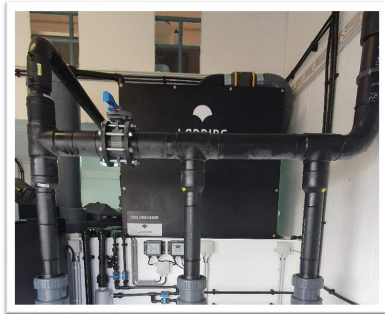
Figura 14 - Desgaseificador usado na SEAentia.
