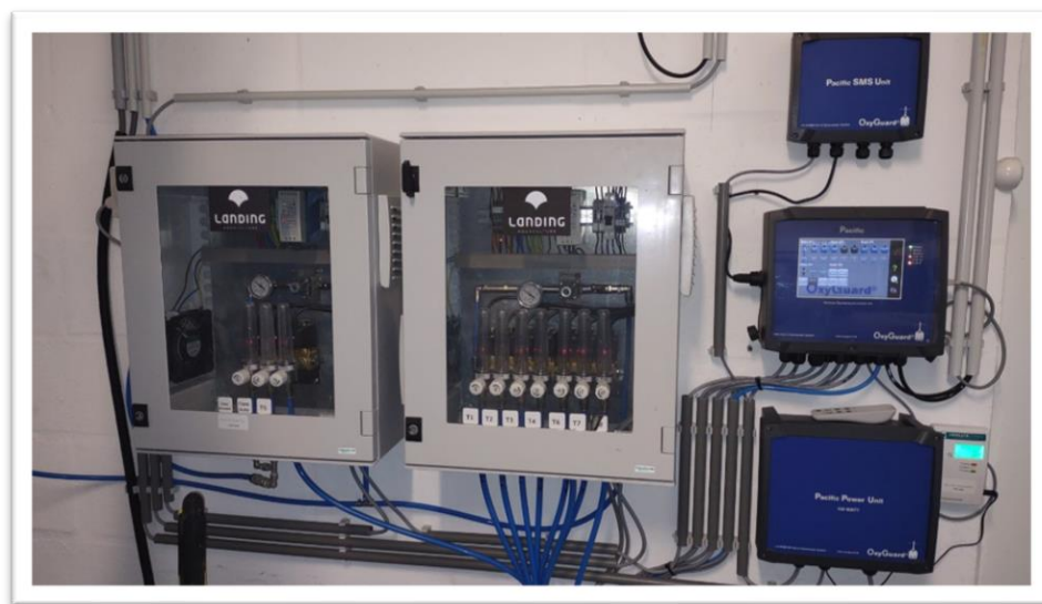
Figura 19 - Sistema central de controlo da Oxyguard e painel de controlo do fluxo de oxigénio
