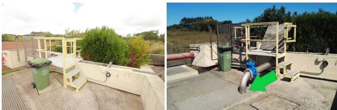
FIGURA 18 ALTERAÇÃO FÍSICA DO ESCOAMENTO AFLUENTE BRUTO - ETAR DO CARREGAL
