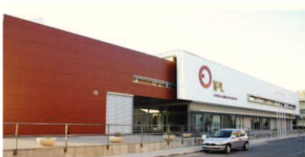
Figura 20 – Vista exterior do edifício
