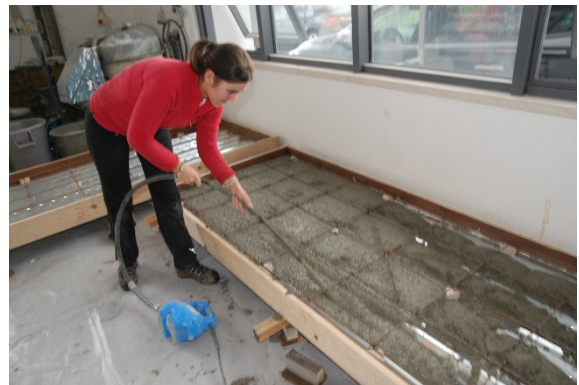
h) Vibração do betão
