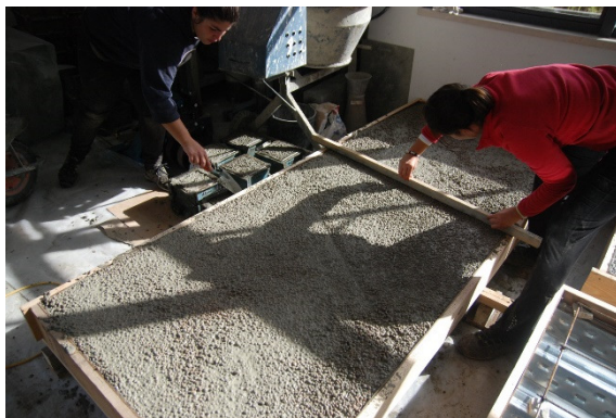
i) Alisamento de superfície
