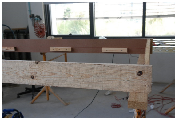
a) Cofragem em madeira
