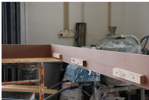
b) Ripas de madeira na bordadura e na largura da cofragem
