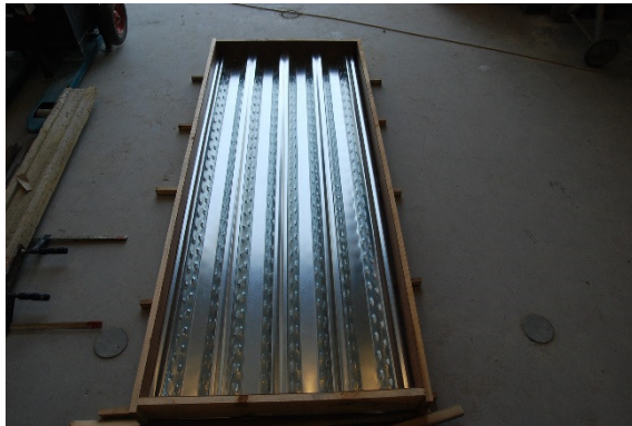
e) Chapa de aço perfilada colocada na cofragem
