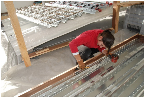
g) Colocação de óleo descofrante
