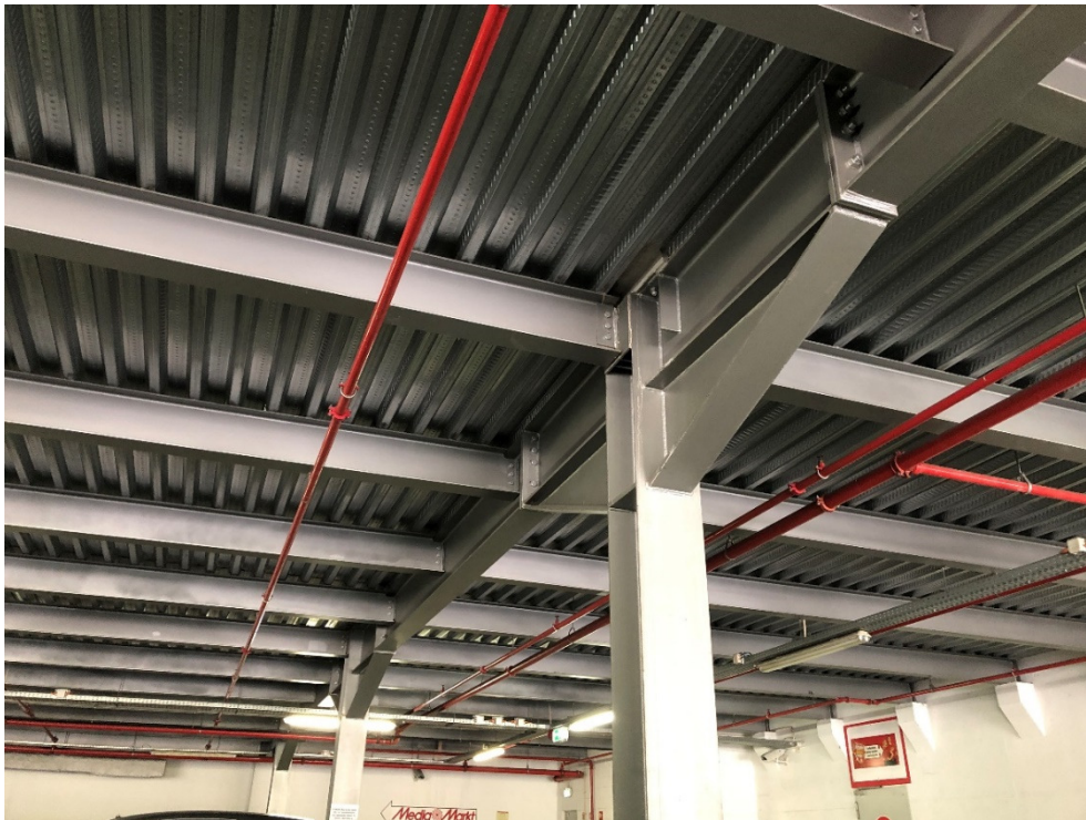
Figura 11 – Edifício comercial com laje mista (arquivo pessoal)
