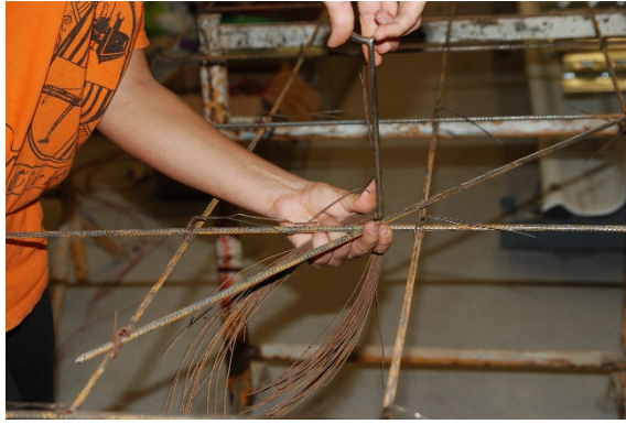
c) Armação da malha de aço
