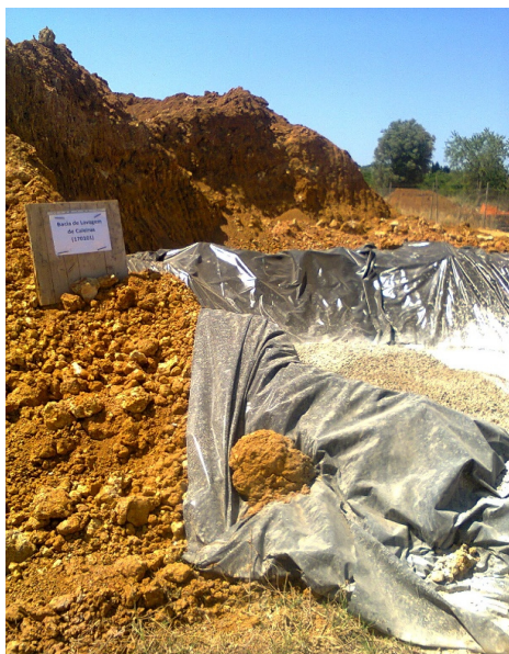
Figura 10 - Zona de lavagem de caleiras
