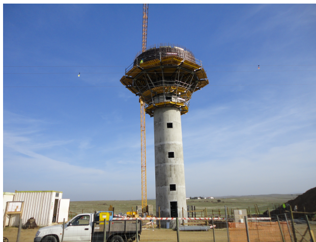
Figura 9 – Construção do reservatório elevado
