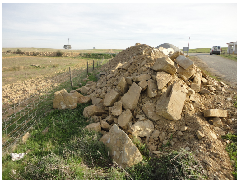
Figura 11 - Produto da escavação e abertura de vala
