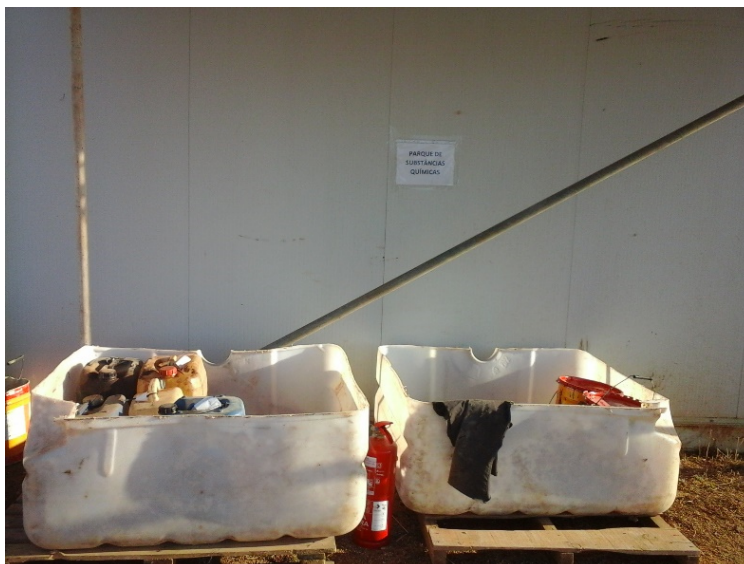
Figura 13 - Bacia de retenção para substâncias perigosas
