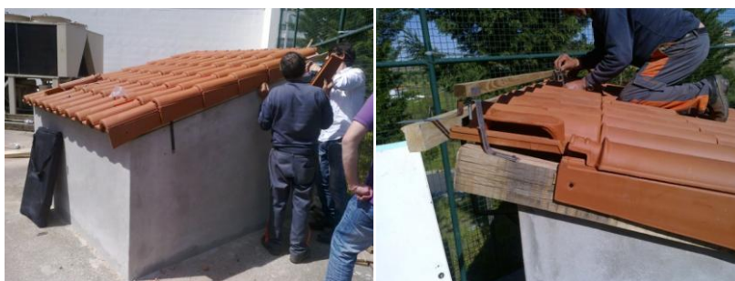
Fig. 3.9 – Colocação da cobertura
