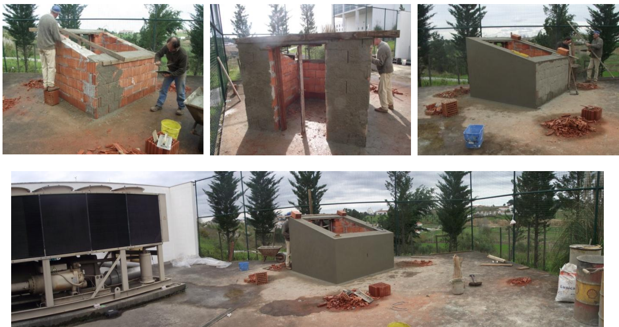
Fig. 3.8.1 – Construção da célula de Teste com Tijolo Térmico: Aplicação do reboco
