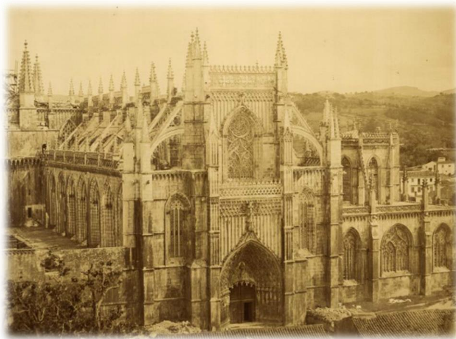
Figura 14 - Fotografia de Vigé & Plessix (1849 a 1873) (Vazão, 2015)
