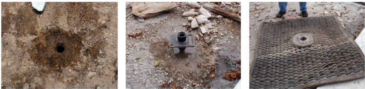
Figura 7 - Preparação de Detonação de Explosivos (Lopes, et al., 2010)
