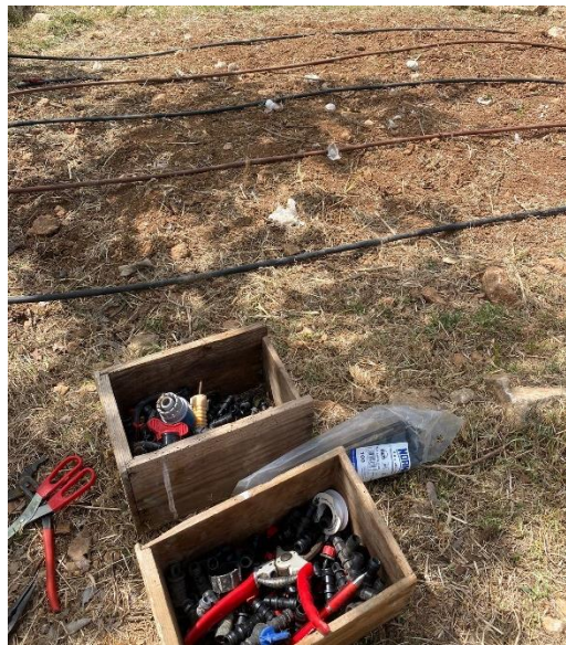
Figura 13 - Reparação de tubos de irrigação. Fonte: Autoria própria.
