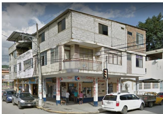
Figura 2.6: Edificación de estructura mixta hormigón armado- acero en Portoviejo. Fuente: Google Maps
