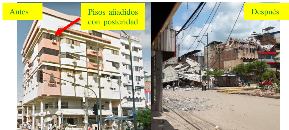
Figura 2.19: Edificio del IEES, fue cambiado su uso constructivo y se adicionaron pisos posteriormente. Fuente: (Aguiar & Mieles, 2016)
