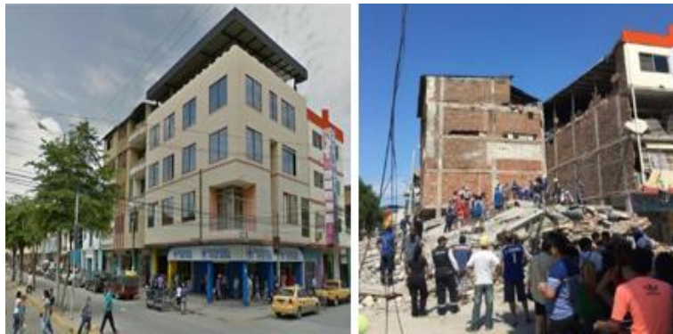
Figura 2.21: Falla por piso blando ( soft storey ). Fuente: (Aguiar & Mieles, 2016)
