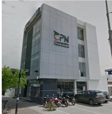
Figura 2.4: Edificio de acero estructural en Portoviejo. Fuente: Google Maps
