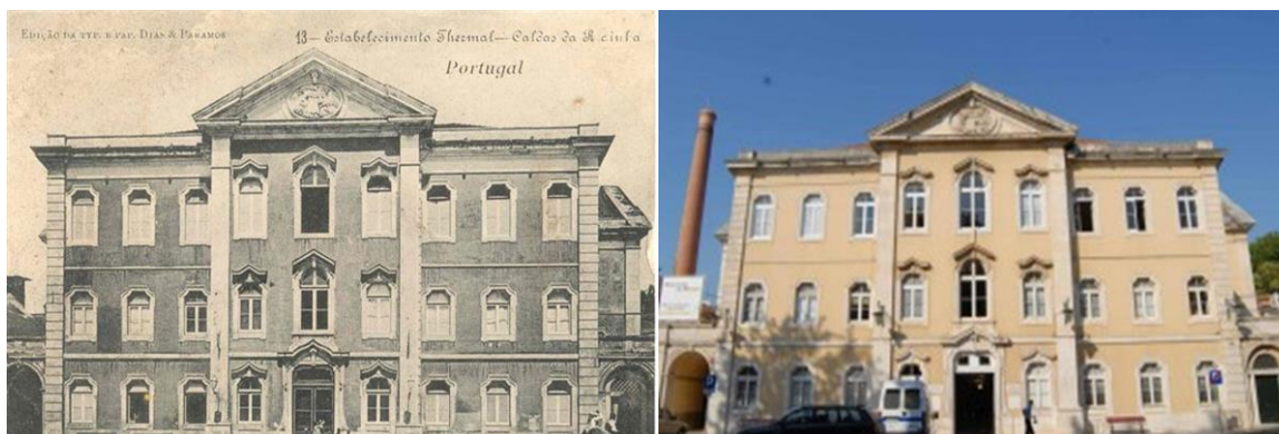
Figura 4 – Edifício do Hospital Termal das Caldas da Rainha no início do Séc. XIX e na atualidade
