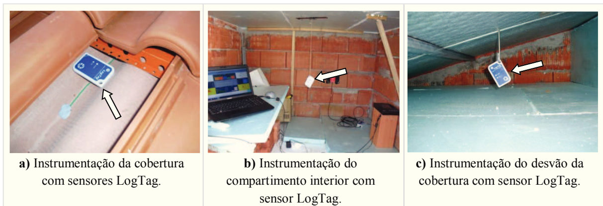
Figura 3.17- Registo fotográfico da instalação dos sensores LogTag.
