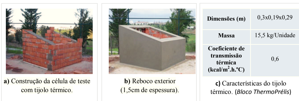
Figura 3.4- Construção das paredes da célula-de-teste.
