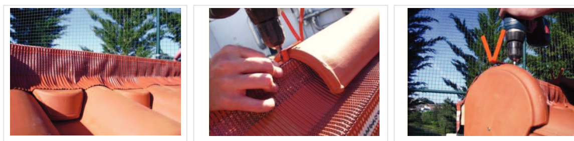
Figura 3.8- Aplicação da membrana e fixação mecânica do telhão com grampo apropriado.
