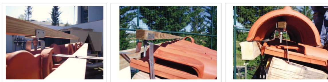
Figura 3.7- Execução da estrutura de suporte da membrana impermeável e do telhão.
