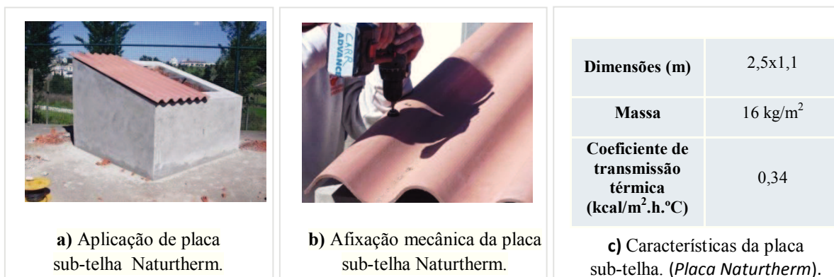
Figura 3.5- Aplicação da placa sub-telha Naturtherm.
