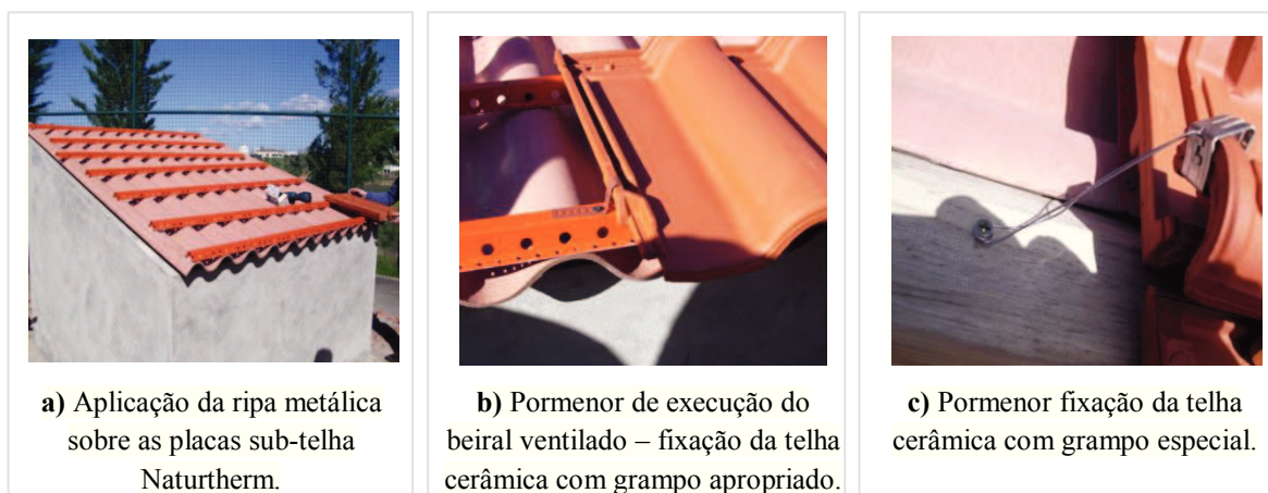
Figura 3.6- Construção da cobertura da célula de teste.
