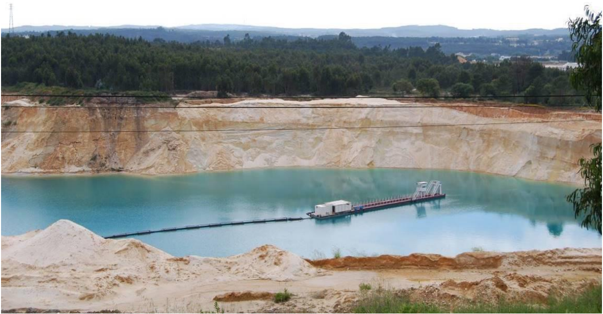
Figura 3.3 - Lagoa da mina Via-Vai - SIFUCEL.
